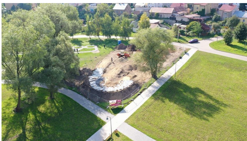
Budowa pumtracku na terenie Parku Solidarności w Grajewie
