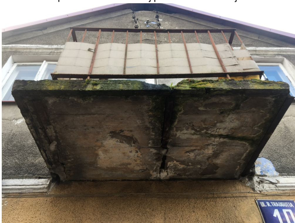
Fot. 4. Elewacja wschodnia – uszkodzenia żelbetowej płyty balkonu, wykwity solne, korozja odsłoniętych stalowych elementów konstrukcyjnych.
