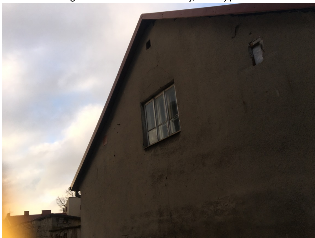
Fot. 12. Elewacja południowa – tynk z widocznymi przebarwieniami,
