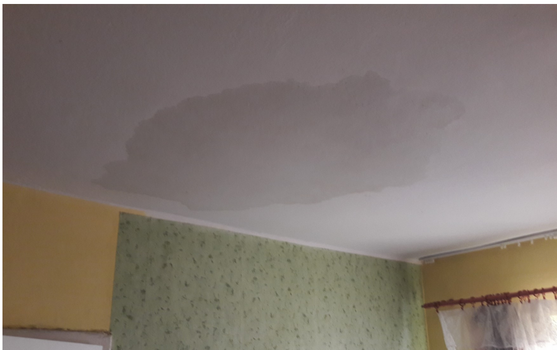
Fot. 26. Lokal mieszkalny nr 3 – zaciek na suficie z instalacji wod-kan.
