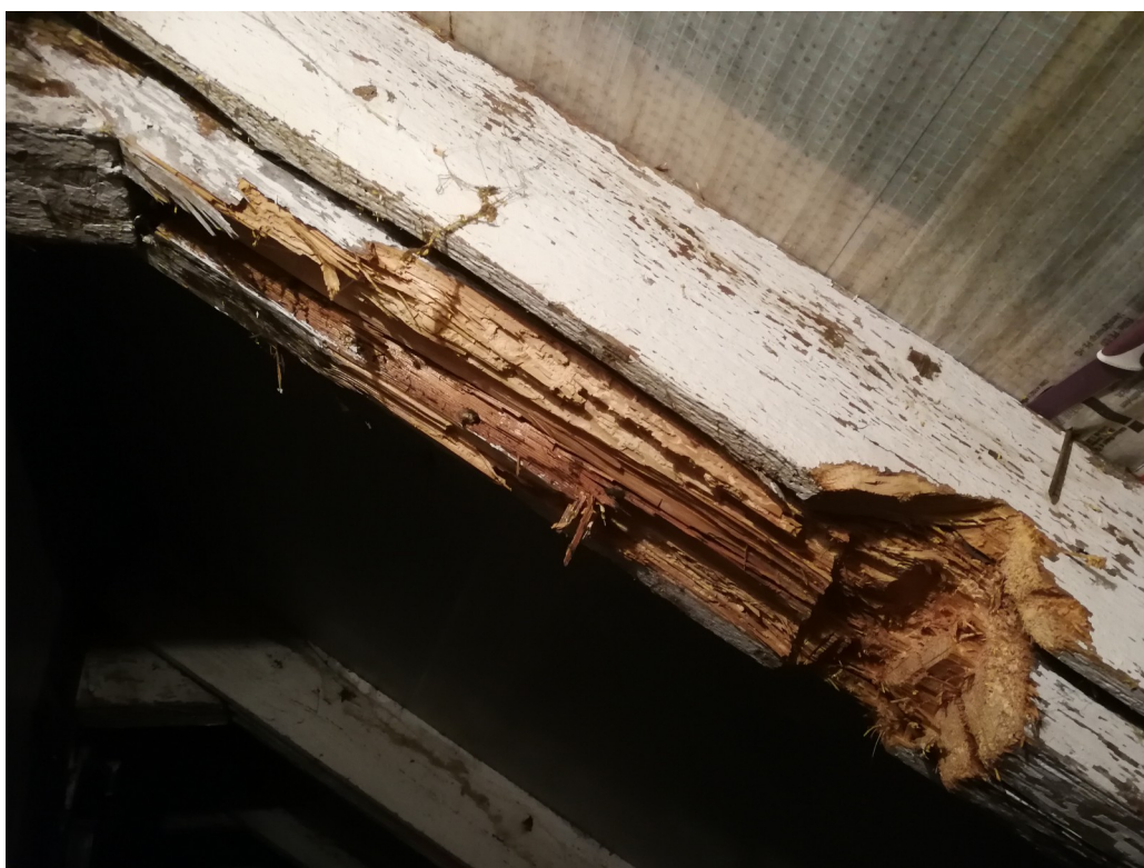
Fot. 29. Strych – biologiczne i mechaniczne uszkodzenie krokwi.
