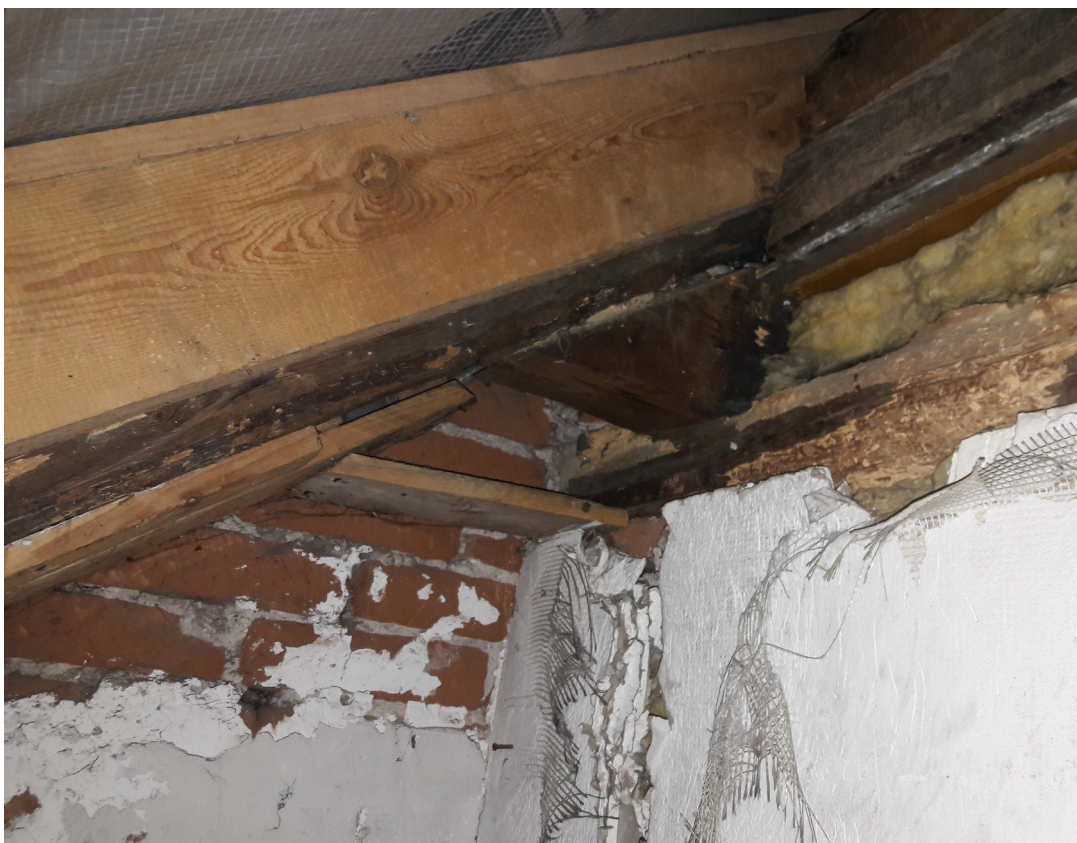
Fot. 28. Strych – wzmocnienie krokwi poprzez montaż nakładek z desek sosnowych.
