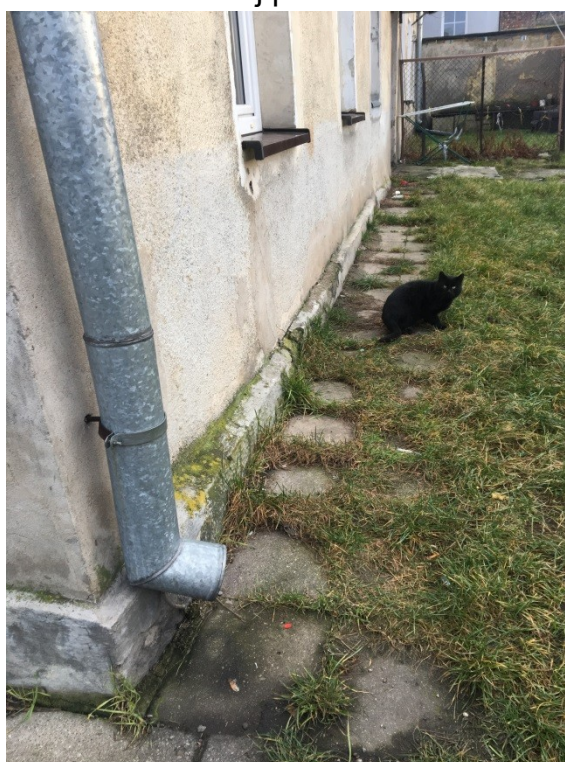
Fot. 10. Elewacja zachodnia – zawilgocenie cokołu przy rurze spustowej, rozwój porostów w strefie cokołowej.
