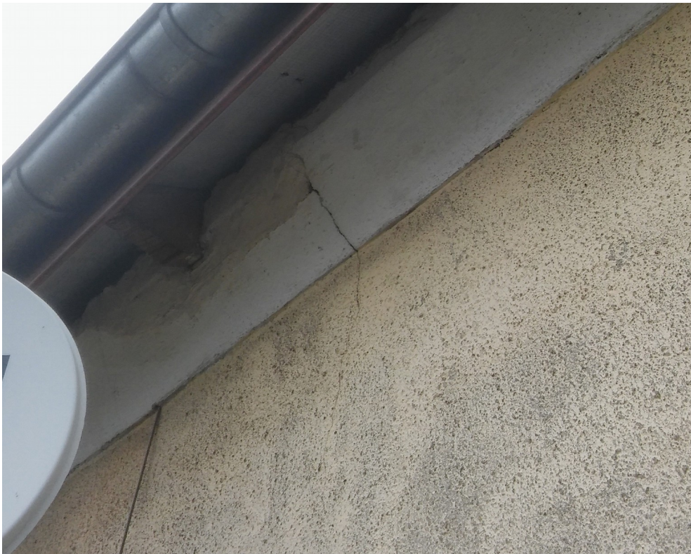
Fot. 31. Elewacja tylna – miejscowe pęknięcie.
