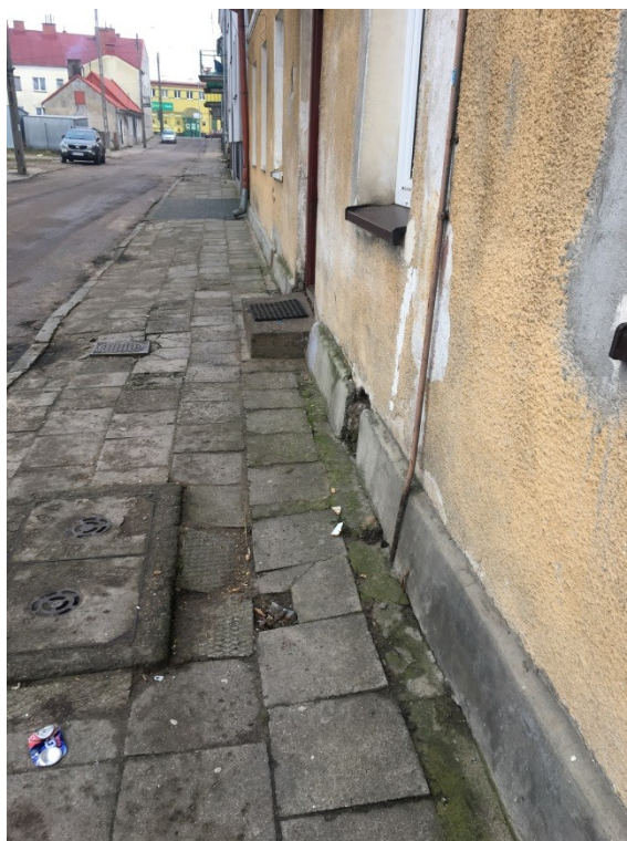
Fot. 5. Elewacja wschodnia – zniszczenia w strefie cokołu, zawilgocenia, rozwój porostów.
