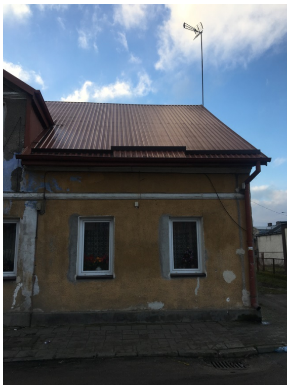
Fot. 3. Elewacja wschodnia – frontowa, strona prawa uszkodzenia tynku, przebarwienia na całej powierzchni elewacji.
