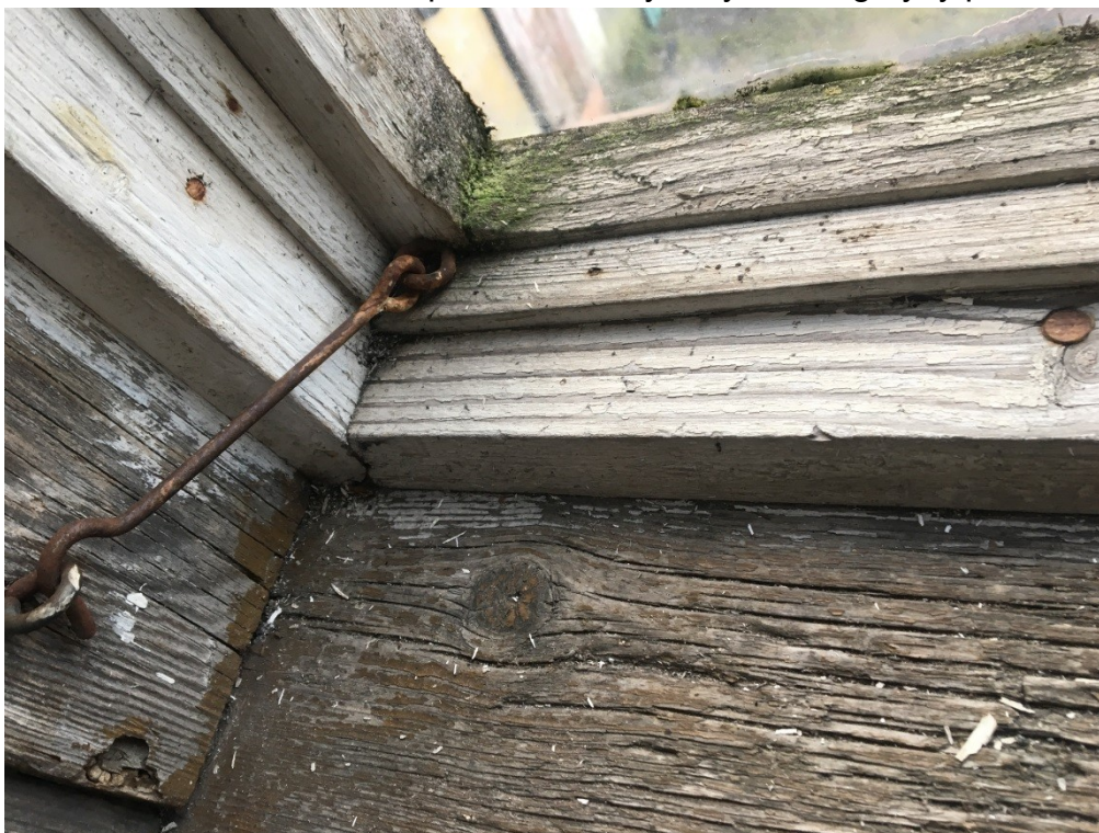
Fot. 22. Klatka schodowa - poddasze – uszkodzenie stolarki okiennej – brak powłoki ochronnej, rozwój mchów i porostów.
