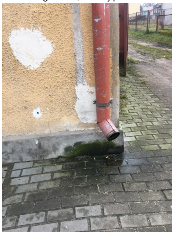
Fot. 6. Elewacja wschodnia – zniszczenia w strefie cokołu, zawilgocenia, rozwój porostów.
