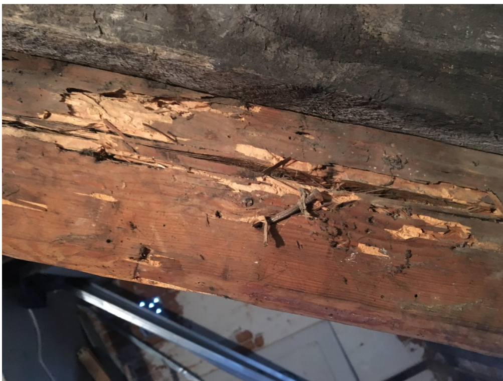
Fot. 19. Klatka schodowa - poddasze – aktywne żerowisko chrząszczy, technicznych szkodników drewna.
