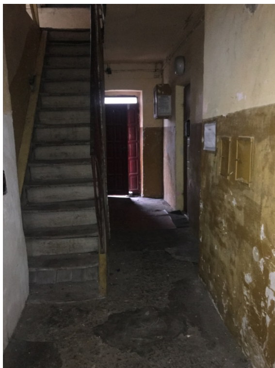
Fot. 15. Korytarz i klatka schodowa – uszkodzenia lamperii olejnych.
