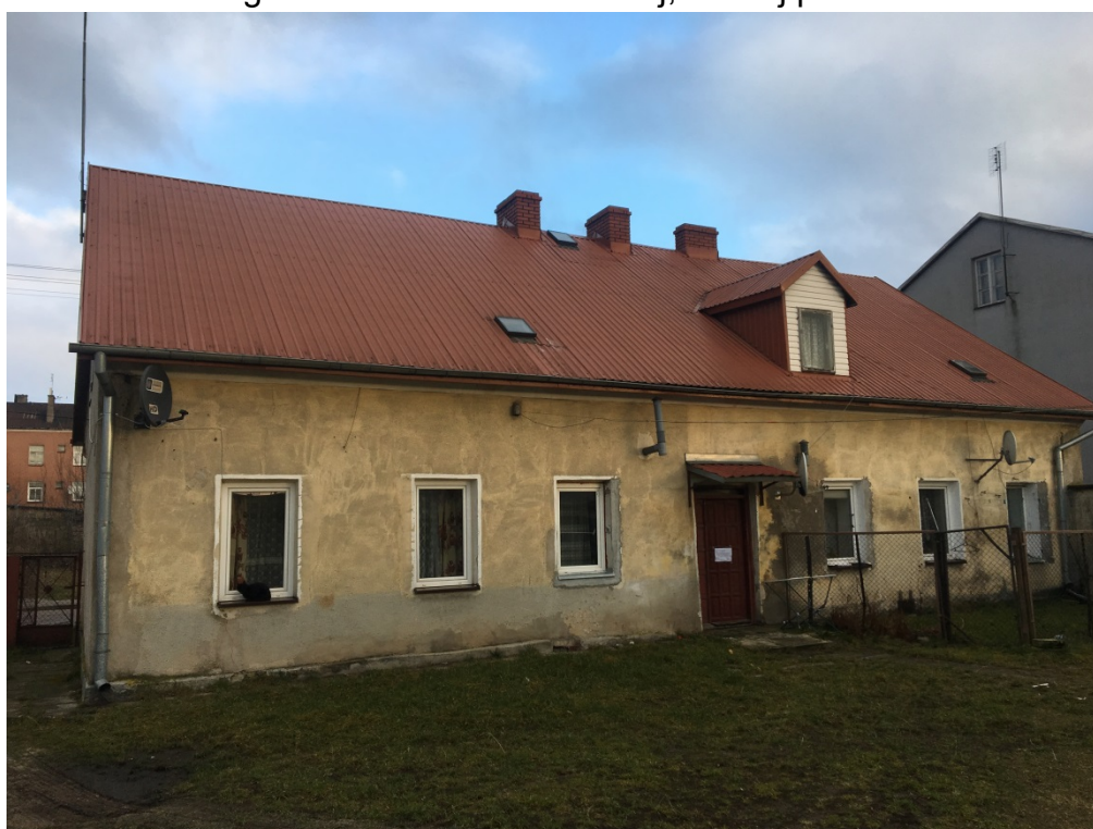
Fot. 8. Elewacja zachodnia – stan ogólny, widoczne przebarwienia, zawilgocenia w strefie cokołowej, rozwój porostów.
