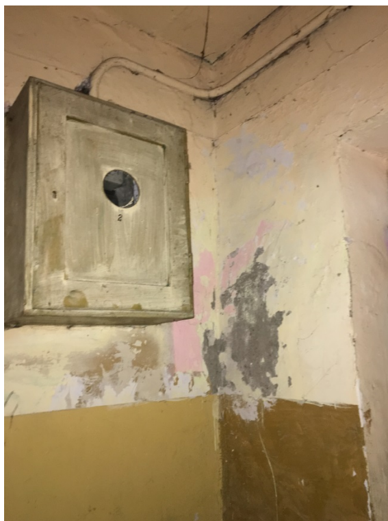
Fot. 17. Korytarz i klatka schodowa – uszkodzenia lamperii olejnych i powłok malarskich powyżej lamperii.
