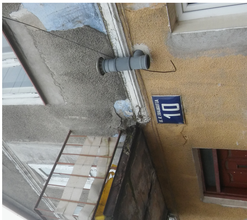
Fot. 27. Elewacja frontowa – nieprawidłowo wykonana wentylacja.
