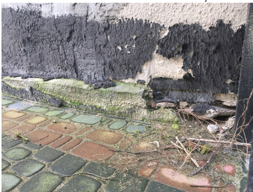
Fot. 14. Elewacja południowa – uszkodzenia bitumicznego uszczelnienia w strefie cokołowej.
