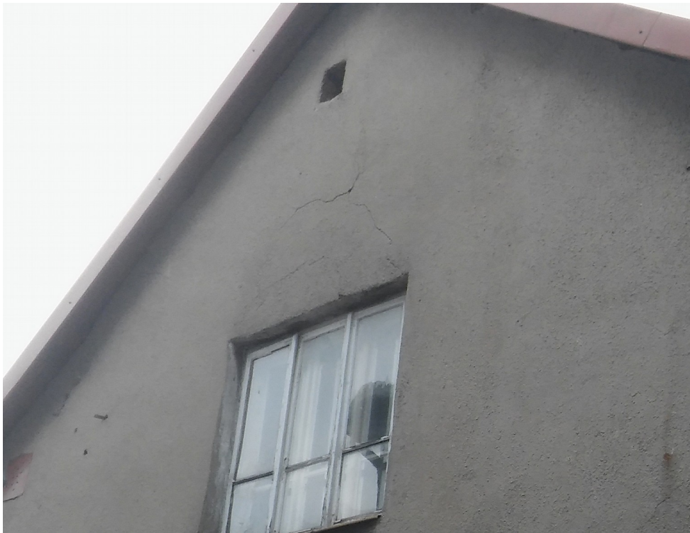
Fot. 30. Elewacja boczna – miejscowe pęknięcie nadproża okiennego.
