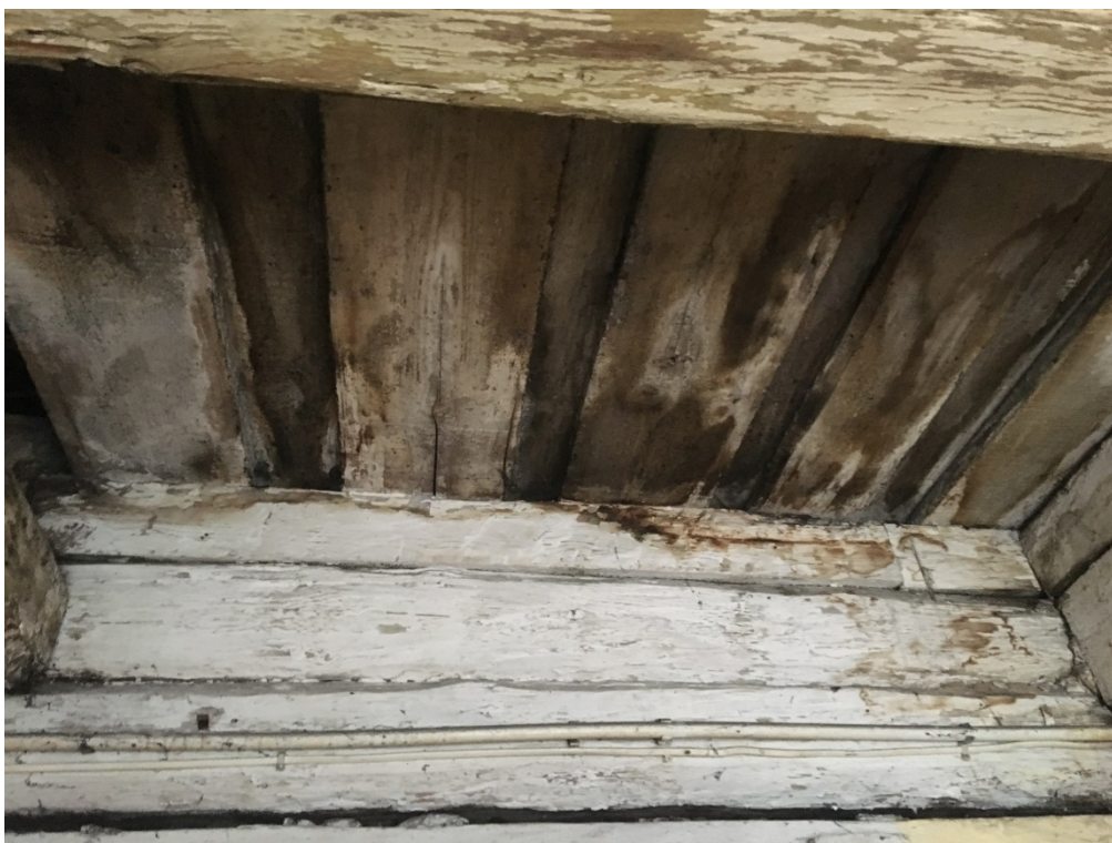
Fot. 21. Klatka schodowa - poddasze – wykwity solne, grzyby pleśniwe.
