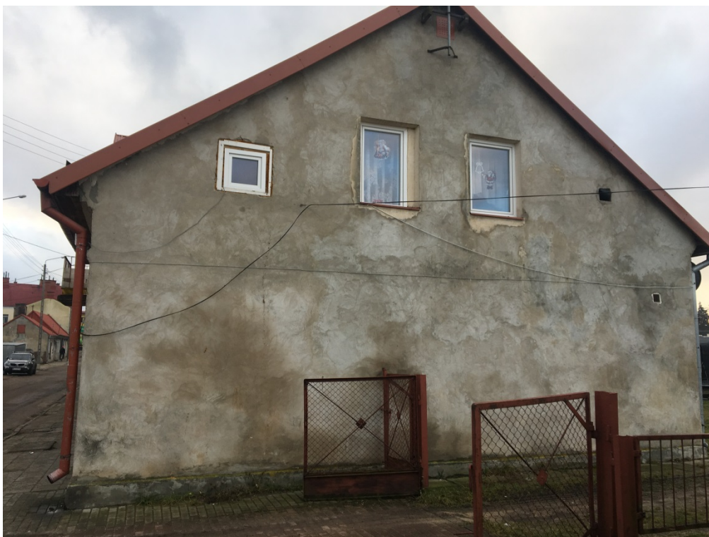
Fot. 7. Elewacja północna – nowe tynki wyrównawcze, widoczne przebarwienia, zawilgocenia w strefie cokołowej, rozwój porostów.
