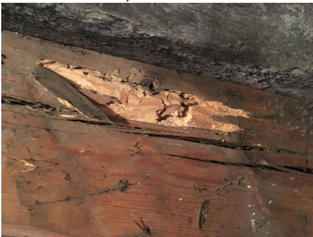
Fot. 20. Klatka schodowa - poddasze – aktywne żerowisko chrząszczy, technicznych szkodników drewna.
