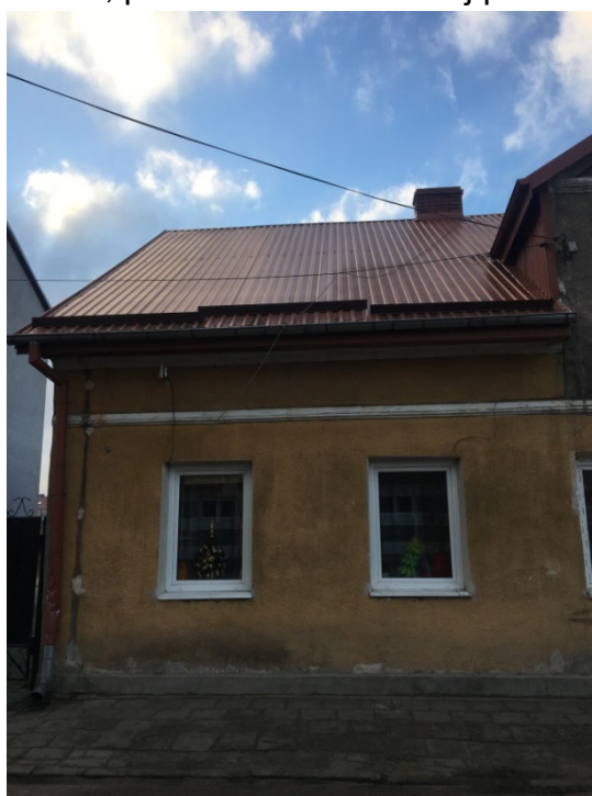
Fot. 2. Elewacja wschodnia – frontowa, strona lewa uszkodzenia tynku, przebarwienia na całej powierzchni elewacji.
