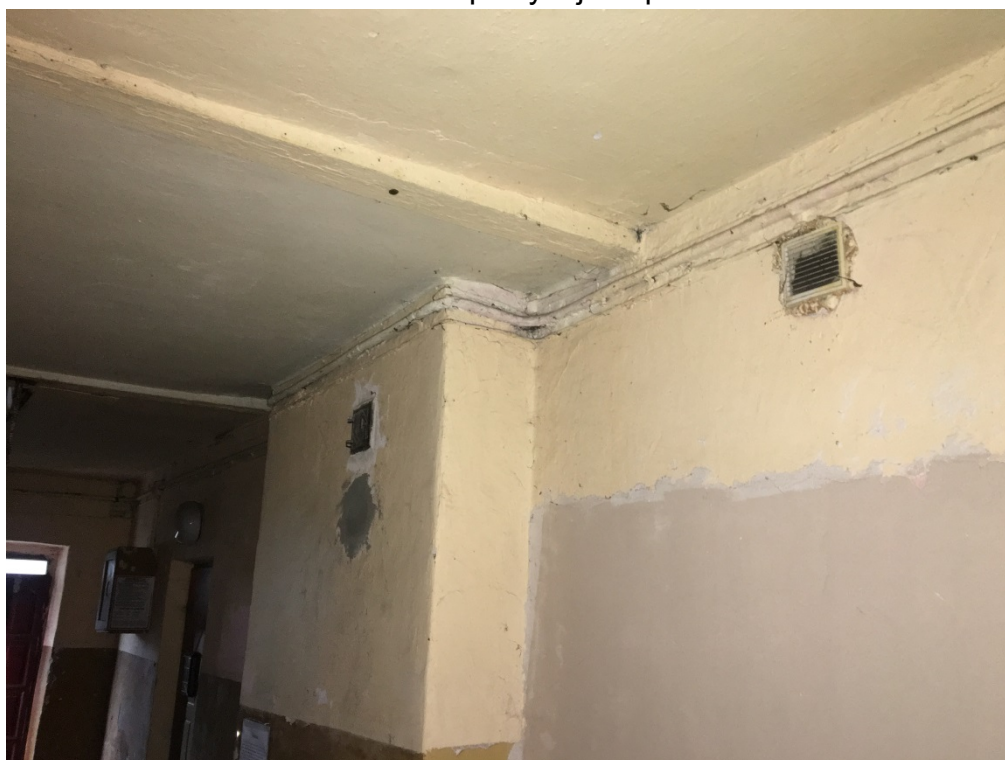
Fot. 18. Korytarz i klatka schodowa – uszkodzenia powłok malarskich.
