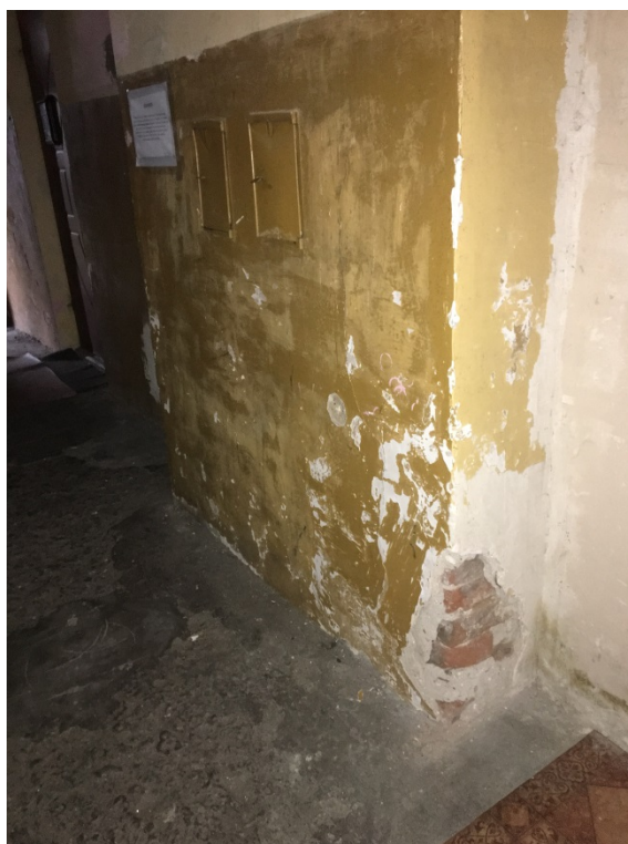
Fot. 16. Korytarz i klatka schodowa – uszkodzenia lamperii olejnych.
