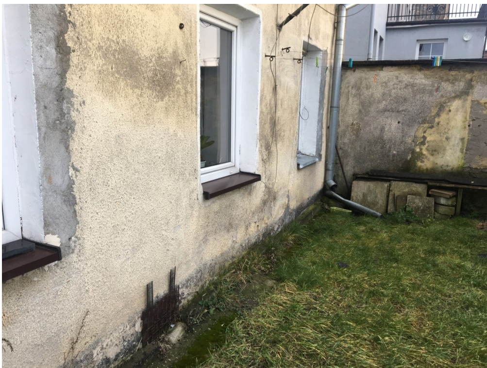
Fot. 9. Elewacja zachodnia – przebarwienia i zawilgocenia w strefie cokołowej, rozwój porostów.
