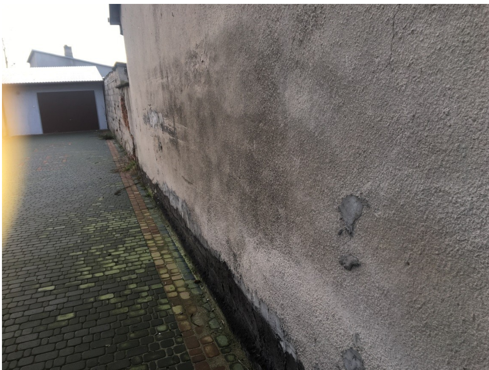
Fot. 13. Elewacja południowa – tynk z widocznymi przebarwieniami, bitumiczne uszczelnienie w strefie cokołowej.
