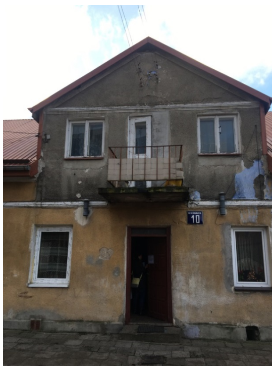
Fot. 1. Elewacja wschodnia – frontowa uszkodzenia tynku, zawilgocenia cokołu, przebarwienia na całej powierzchni elewacji.
