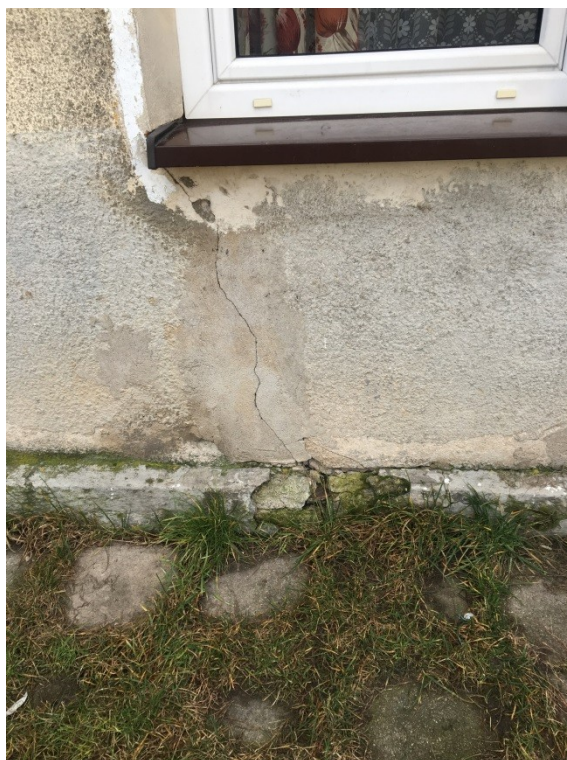
Fot. 11. Elewacja zachodnia – pęknięcie ściany przy oknie, zawilgocenia w strefie cokołowej, rozwój porostów.
