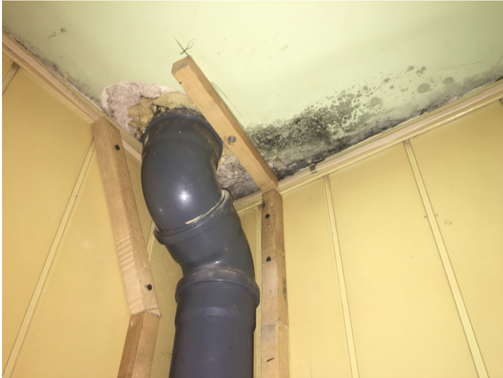
Fot. 22. Lokal mieszkalny nr... –rozwój grzybów pleśniowych na suficie.
