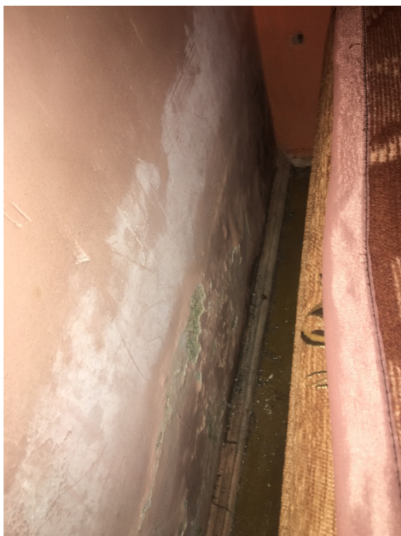
Fot. 24. Lokal mieszkalny nr ... - ściana od ul. Kilińskiego – zawilgocenia w strefie przypodłogowej, wysolenia i rozwój grzybów pleśniowych.
