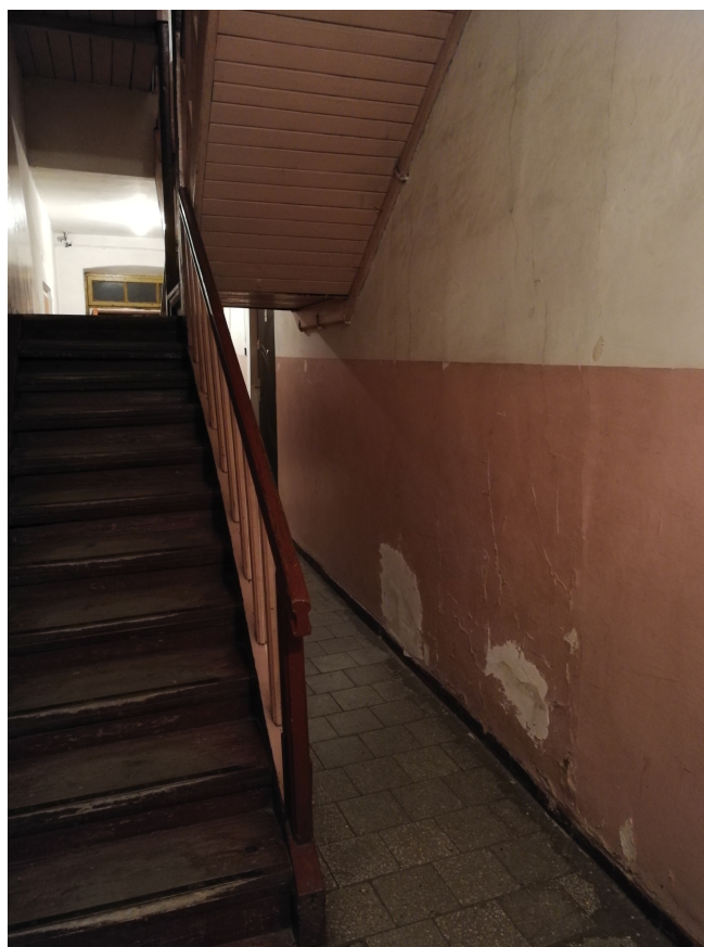
Fot. 14. Ślady zużycia wypraw tynkarskich i malarskich klatki schodowej oraz wyeksploatowania schodów.
