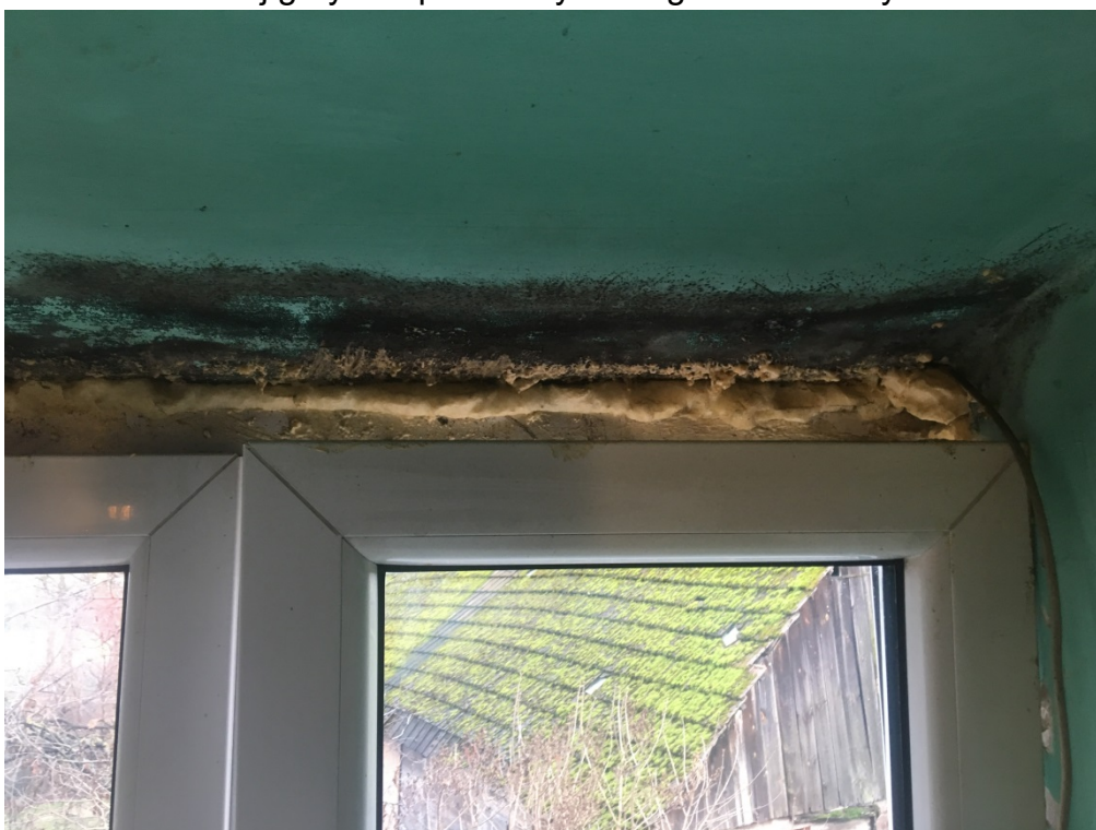
Fot. 20. Lokal mieszkalny nr 3 - rozległe powierzchnie porażenia biologicznego, rozwój grzybów pleśniowych na glifach okiennych.
