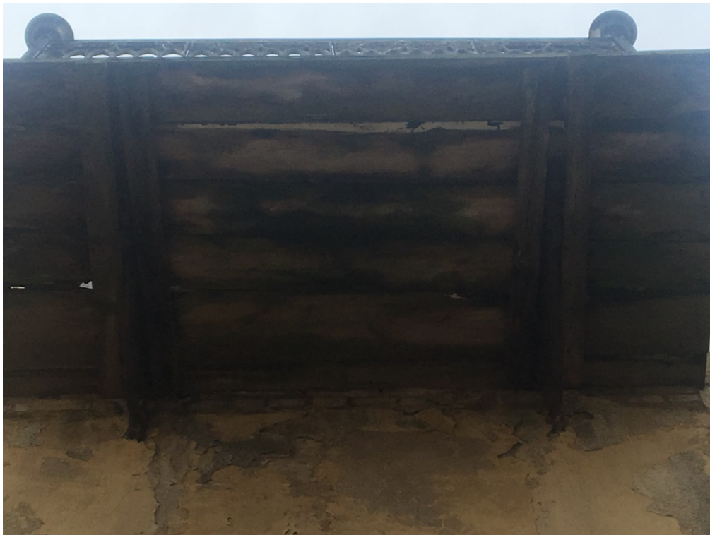
Fot. 7. Elewacja wschodnia - balkon – biologiczny rozkład desek balkonowych, odspojenie powłok malarskich.
