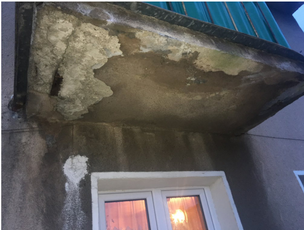
Fot.5. Elewacja południowa – uszkodzenia żelbetowej płyty balkonu, wykwity solne, odsłonięte stalowe elementy konstrukcyjne.
