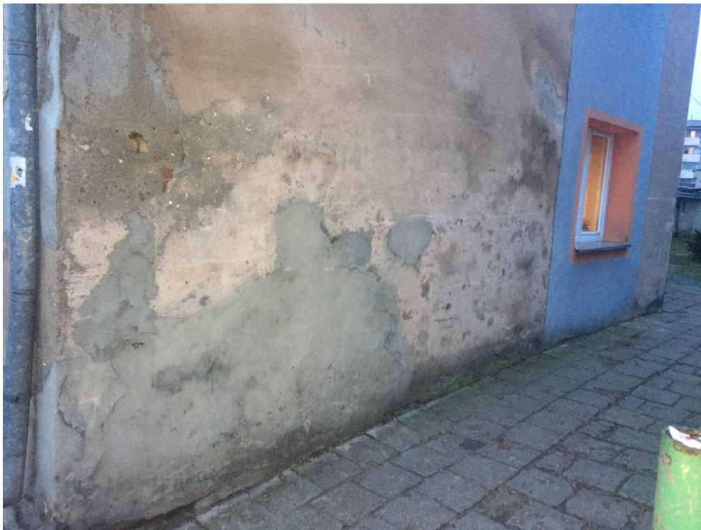
Fot.9. Elewacja wschodnia – liczne uszkodzenia tynku w strefie przyziemia.
