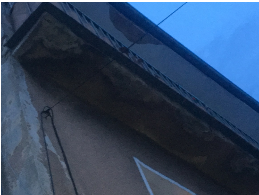
Fot.7. Elewacja południowa – uszkodzenia żelbetowej płyty balkonu drugiego piętra typu loggia, liczne ubytki tynku i wykwity solne.
