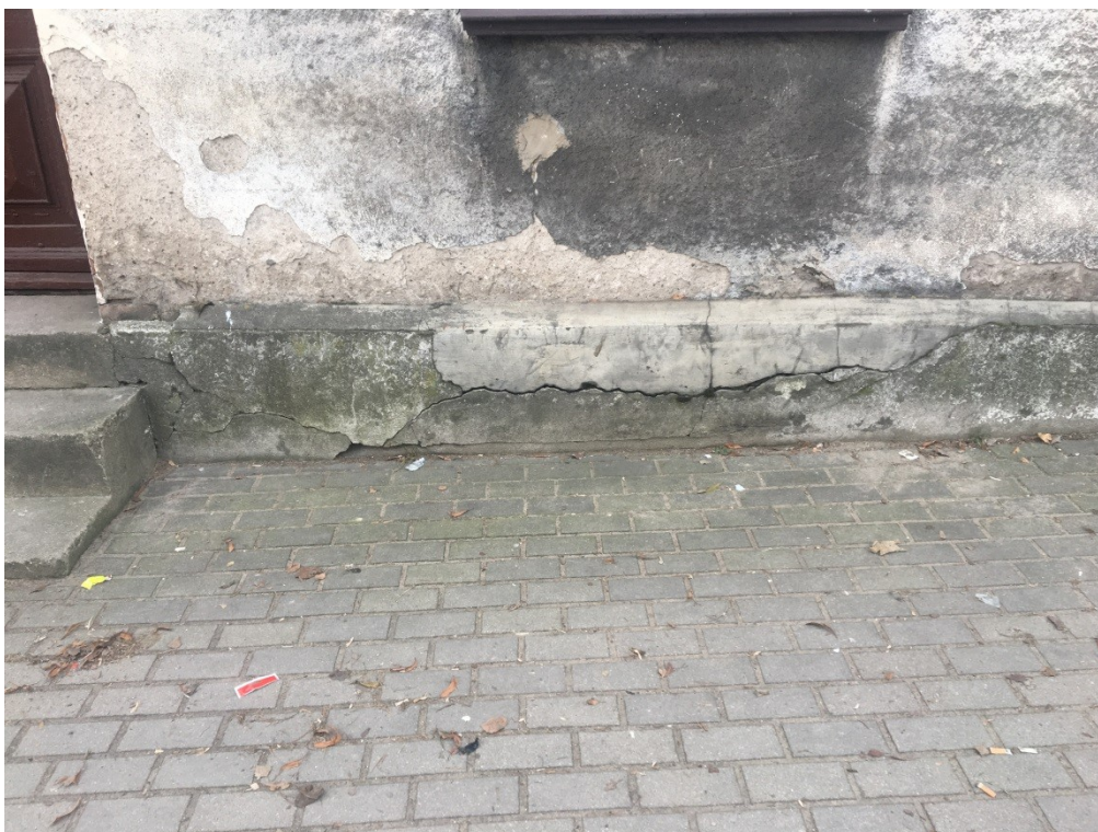
Fot. 3. Elewacja północna – uszkodzenia cokołu, rozwój porostów w strefie cokołowej.
