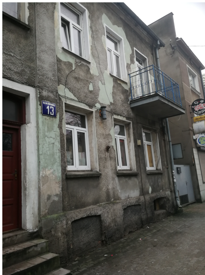
Fot. 21 Widoczne spękania na elewacji frontowej.
