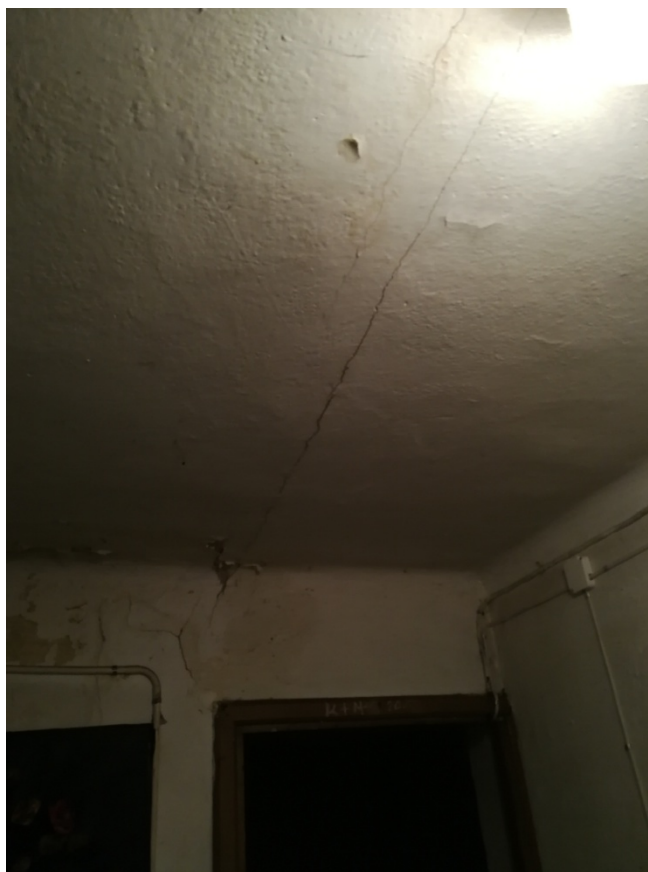
Fot. 30 Widoczne pęknięcia warstw konstrukcyjnych stropodachu na kondygnacji II pietra
