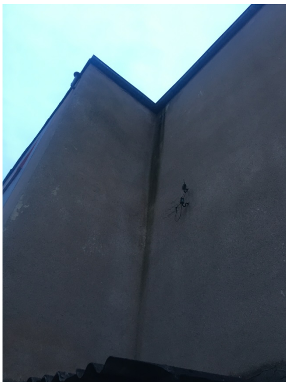
Fot.10. Elewacja pn.-wsch. – uszkodzenia narożnika spowodowane przeciekami wód opadowych z nieszczelnych rynien.
