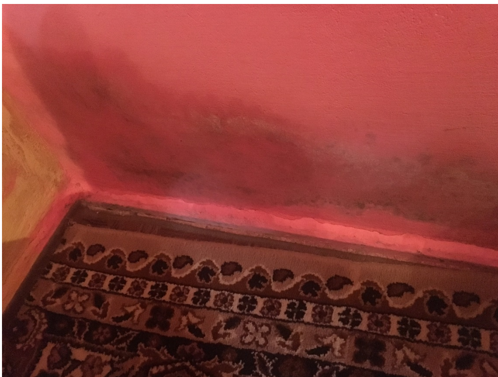
Fot. 13. Lokal mieszkalny nr 1 - wilgotne ściany przy podłodze, rozwój grzybów pleśniowych.
