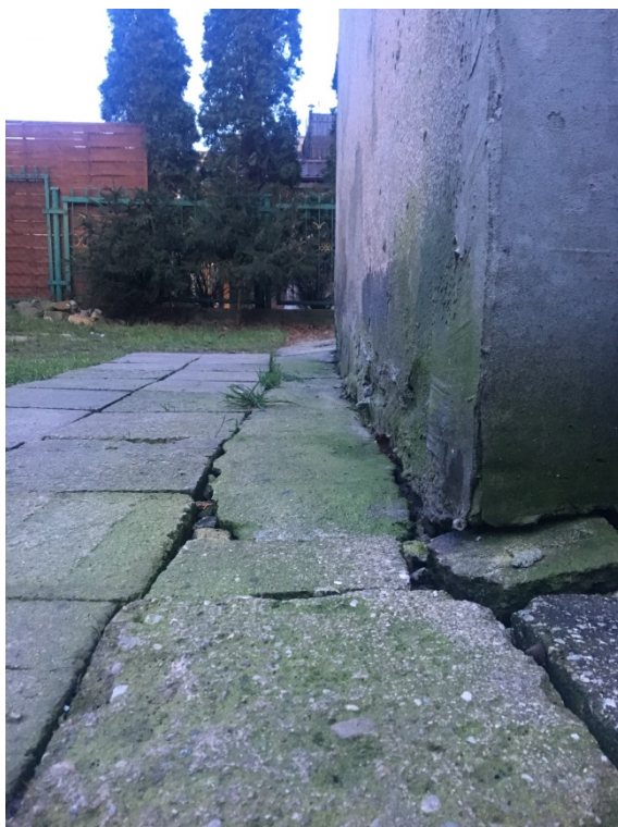
Fot. 14. Elewacja północna – klatka schodowa – rozwój grzybów pleśniowych i porostów.
