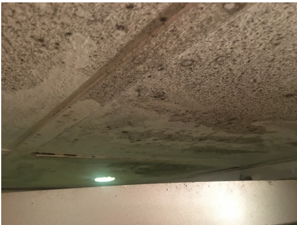
Fot. 15. Lokal mieszkalny nr 3 - rozwój grzybów pleśniowych na suficie w łazience.
