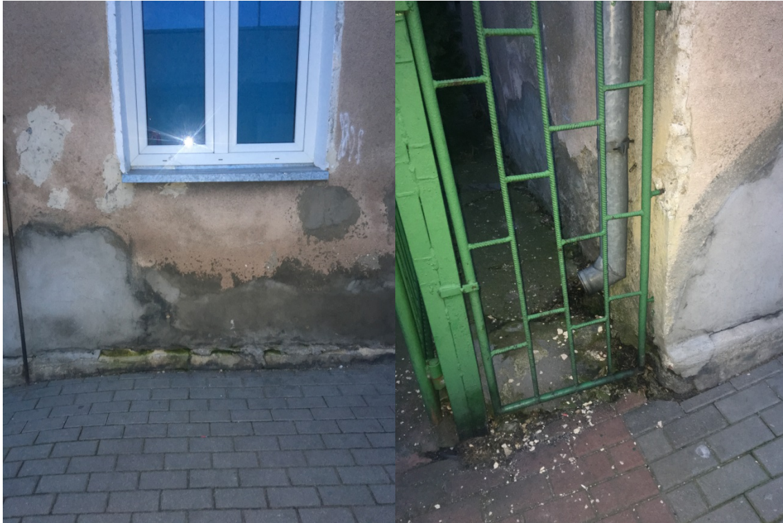
Fot.3, 4. Elewacja południowa – uszkodzenia wypraw tynkarskich w strefie cokołu.
