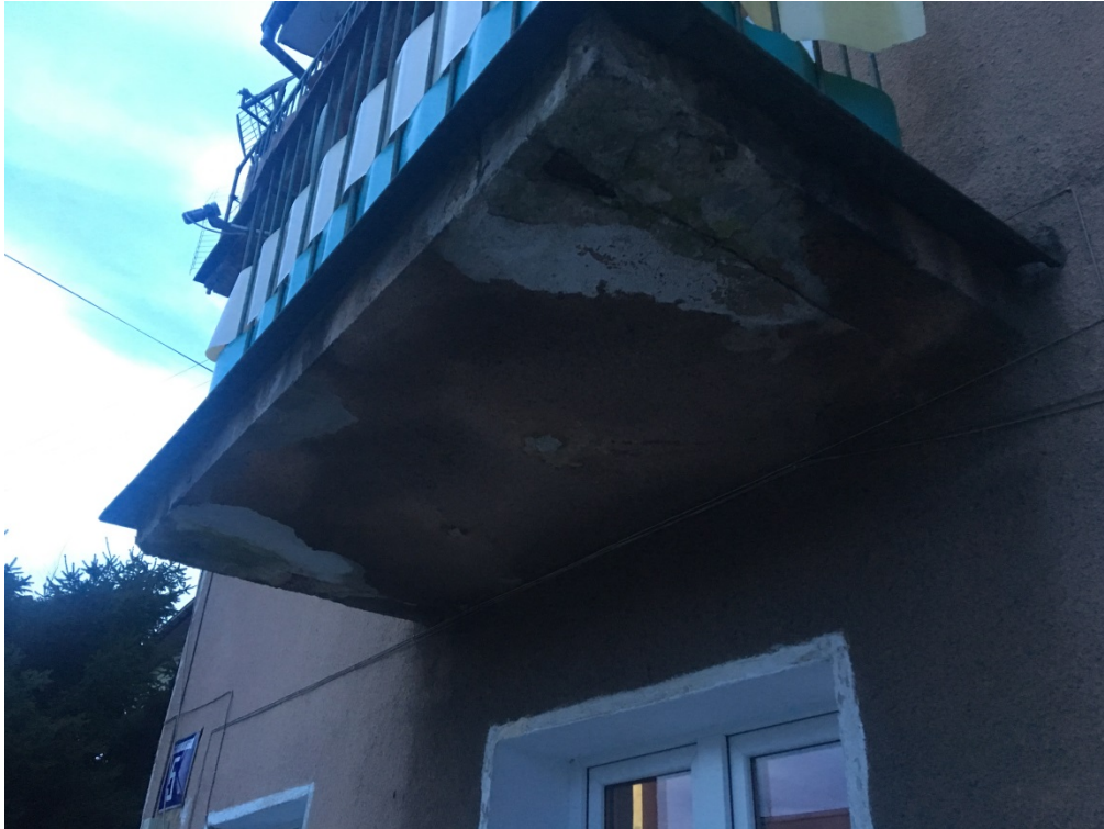
Fot.6. Elewacja południowa – uszkodzenia żelbetowej płyty balkonu, wykwity solne, odsłonięte stalowe elementy konstrukcyjne.
