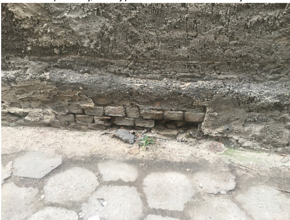
Fot. 6. Elewacja wschodnia – uszkodzenia cokołu ubytki w murze ceglanym.
