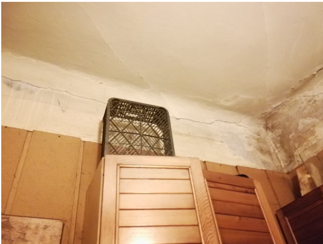
Fot. 19 Widoczne spękania ścian wewnętrznych
