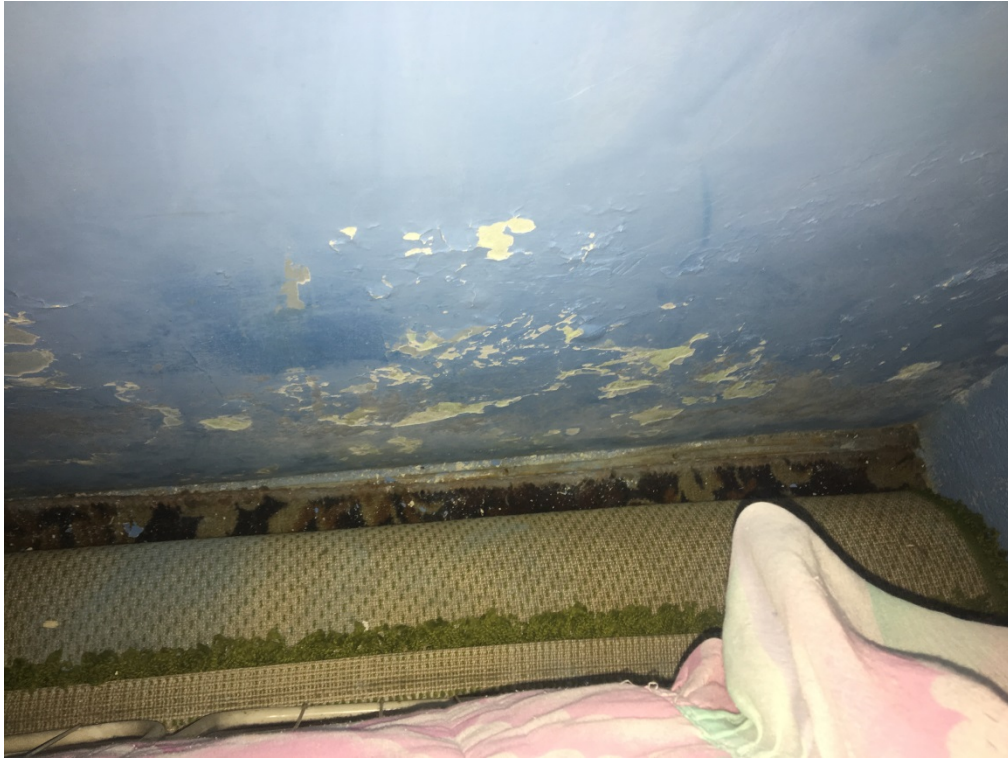
Fot. 28. Lokal mieszkalny nr ... - ściana od ul. Kilińskiego – zawilgocenia w strefie przypodłogowej, wysolenia i rozwój grzybów pleśniowych.
