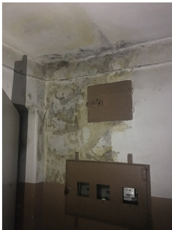
Fot. 18. Klatka schodowa – uszkodzenia spowodowane zalewaniem wodami opadowymi z nieszczelnych rynien w elewacji pn.-zach. (narożnik).
