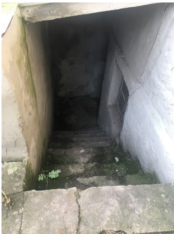
Fot. 9. Elewacja południowa – wejście do piwnic, zawilgocenia od wód opadowych, rozwój mchów i porostów.
