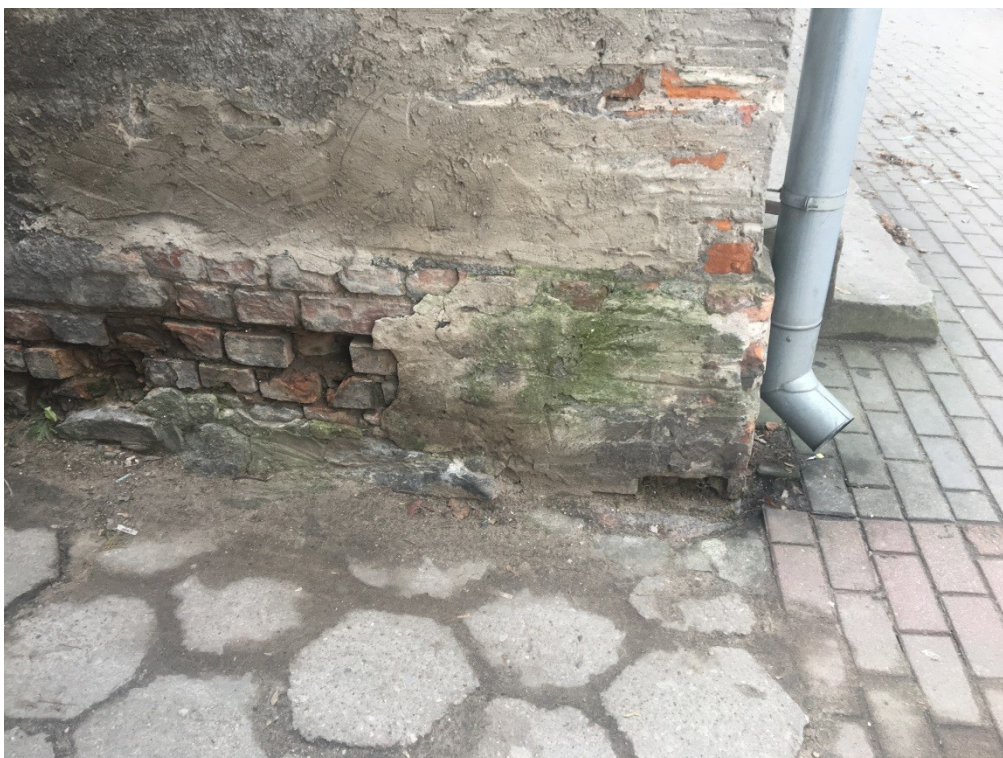
Fot. 5. Elewacja wschodnia – uszkodzenia cokołu przy rurze spustowej, rozwój porostów w strefie cokołowej.
