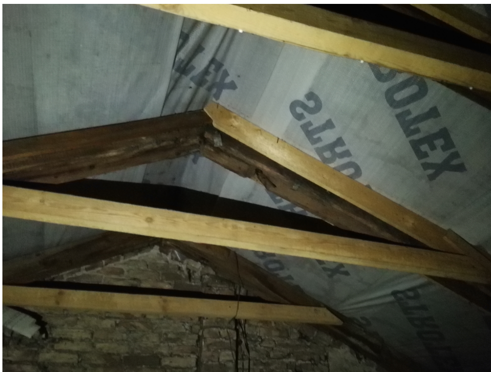
Fot. 13. Widok dodatkowych wzmocnień więźby dachowej
