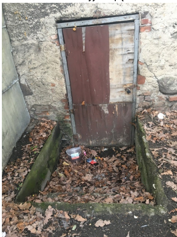
Fot. 10. Elewacja wschodnia– wejście do piwnic, zawilgocenia od wód opadowych, rozwój mchów i porostów.
