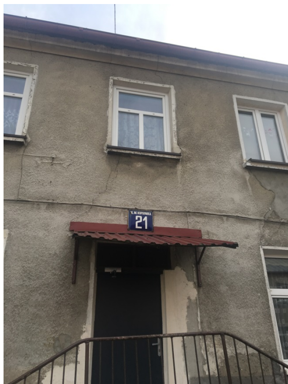
Fot. 1. Elewacja północna – frontowa uszkodzenia tynku i brudne przebarwienia na całej powierzchni elewacji.
