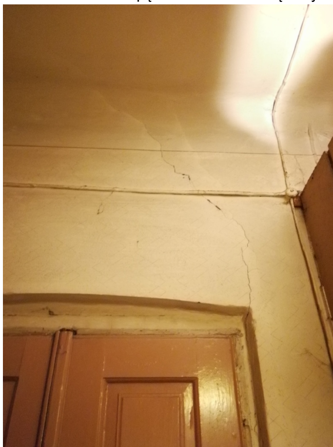
Fot. 18 Widoczne spękania ścian wewnętrznych i nadproży
