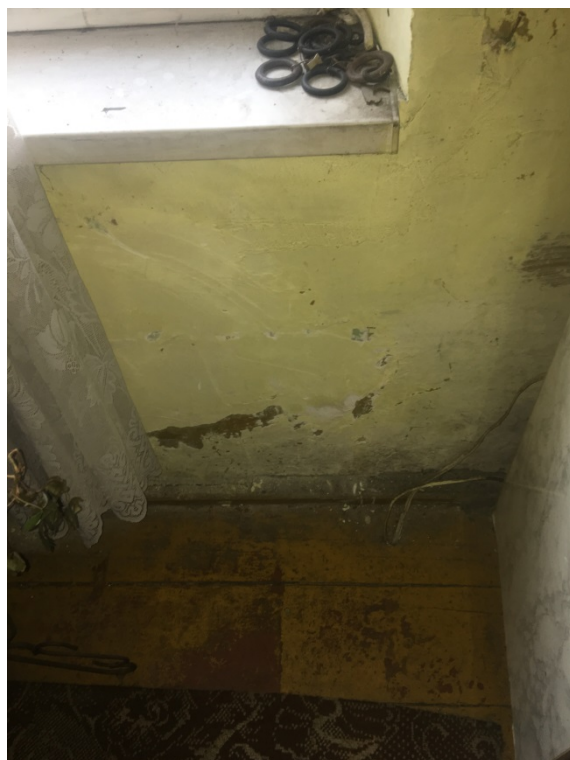
Fot. 11. Lokal mieszkalny nr ... – uszkodzenia tynku i przebarwienia powłok malarskich, ślady rozwoju grzybów pleśniowych w narożu przy podłodze.
