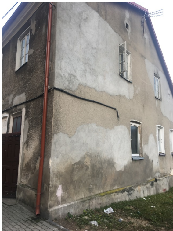
Fot. 5. Elewacja południowa – zawilgocenia strefy cokołowej, liczne uzupełnienia i odspojenia i spękania tynku.
