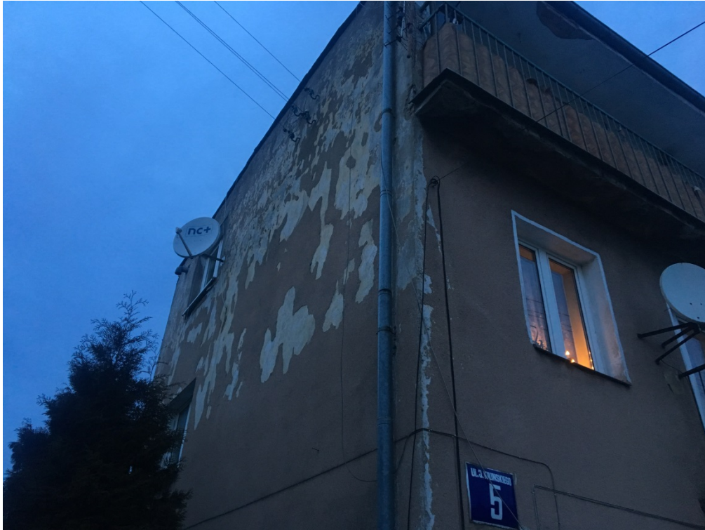
Fot.8. Elewacja zachodnia – liczne odspojenia wypraw tynkarskich.
