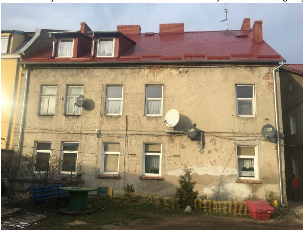
Fot. 8. Elewacja południowa – uszkodzenia tynku i przebarwienia na całej powierzchni elewacji.
