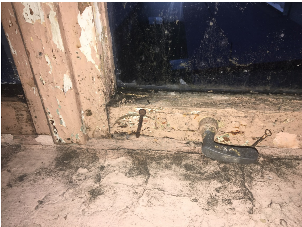
Fot. 23. Klatka schodowa – stolarka okienna, złuszczenia powłok malarskich, rozwój grzybów pleśniowych.
