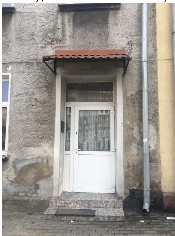
Fot. 4. Elewacja północna – uszkodzenia cokołu przy rurze spustowej, rozwój porostów w strefie cokołowej.
