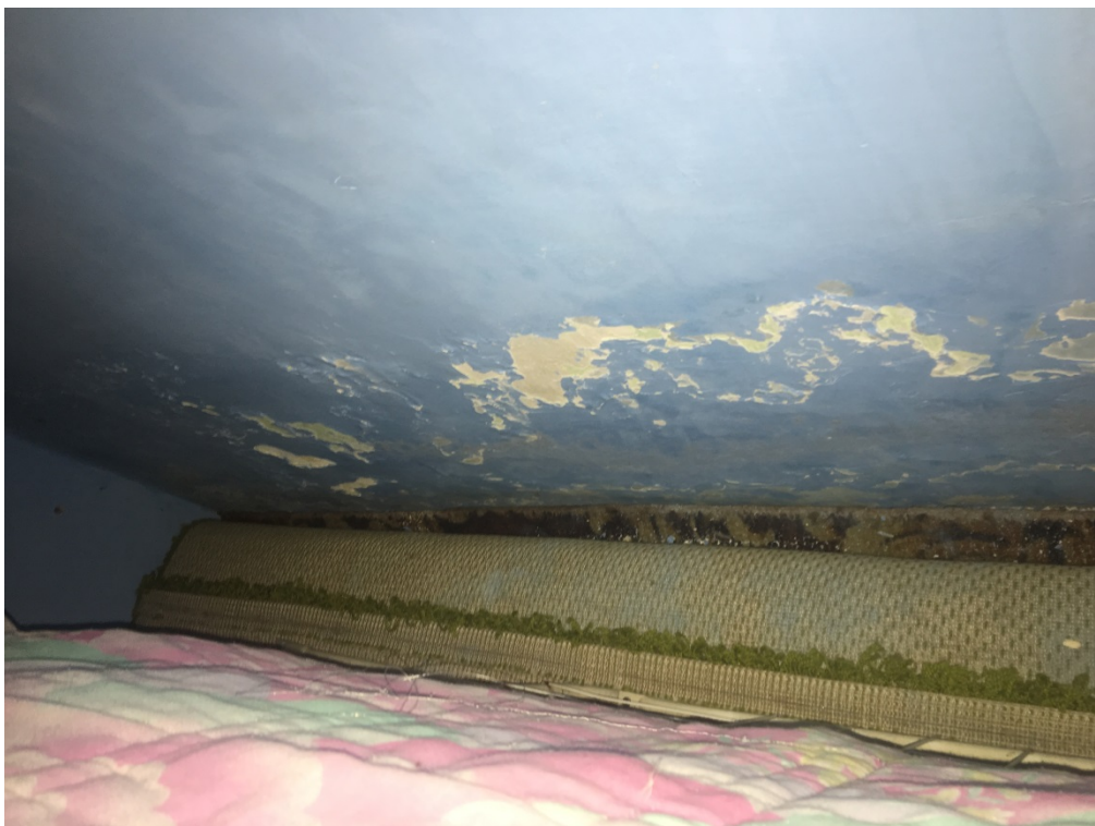
Fot. 27. Lokal mieszkalny nr ... - ściana od ul. Kilińskiego – zawilgocenia w strefie przypodłogowej, uszkodzenia spowodowane krystalizacją soli budowlanych.
