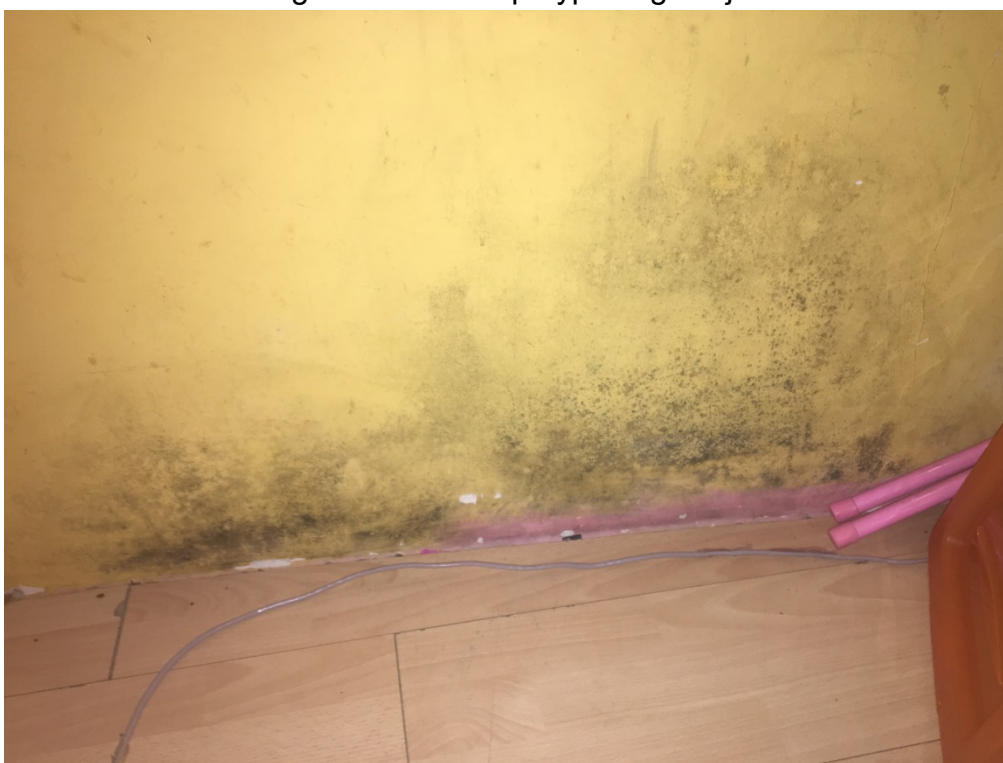
Fot. 12. Lokal mieszkalny nr... - uszkodzenie powłok malarskich rozwój grzybów pleśniowych w strefie przypodłogowej.
