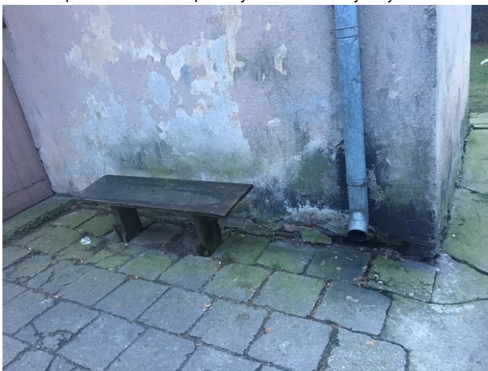
Fot. 11. Elewacja wschodnia – ściana budynku klatki schodowej - uszkodzenia powłok malarskich i tynków, zawilgocenie cokołu w strefie zygacza rury spustowej.
