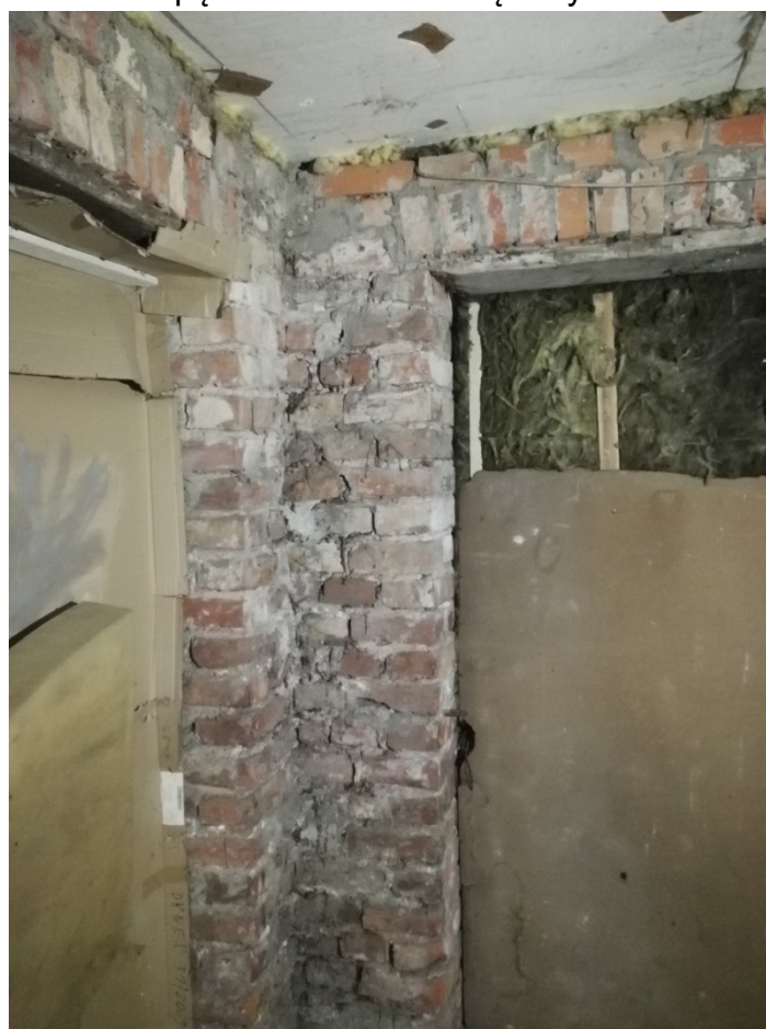
Fot. 22 Widoczne spękania ścian wewnętrznych na kondygnacji piwnicy.
