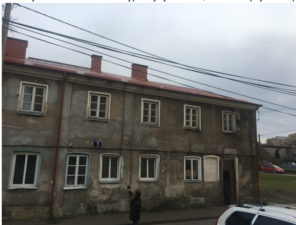
Fot. 2. Elewacja zachodnia – słabe wyprawy tynkarskie, liczne odspojenia i spękania.
