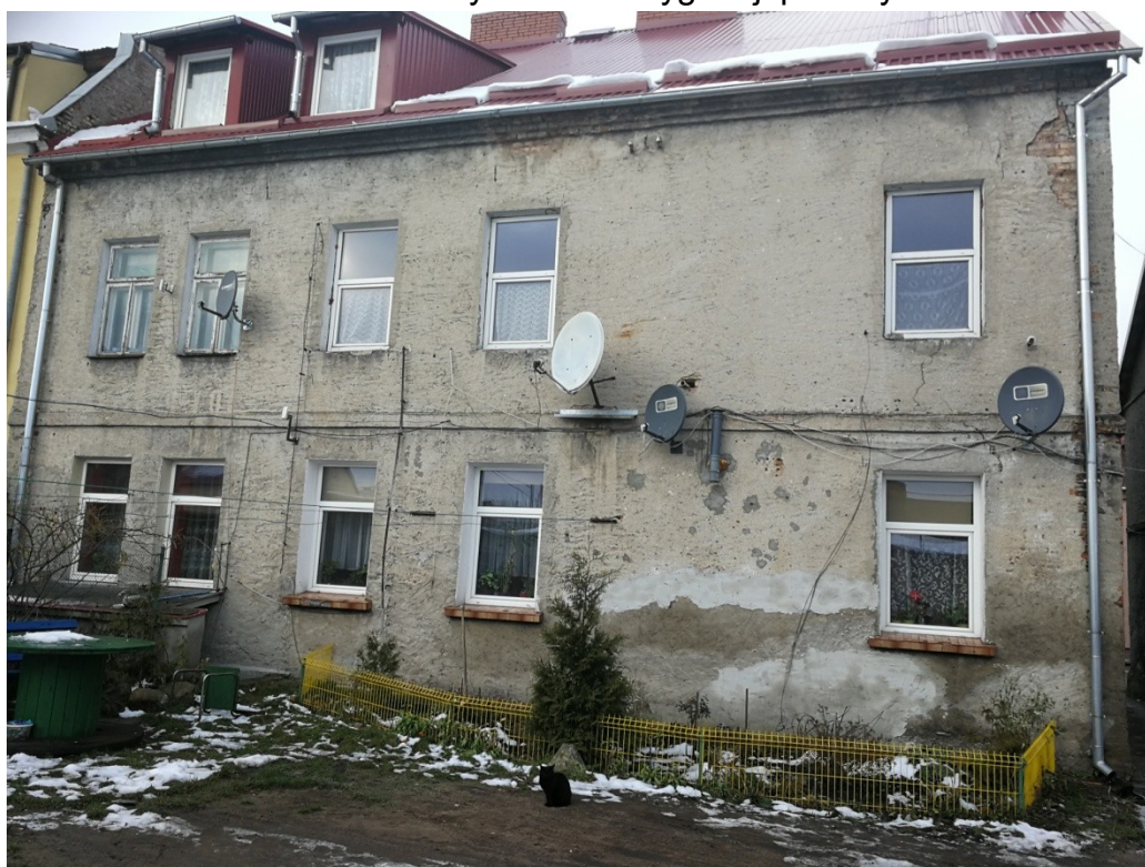
Fot. 16 Widok na spękania ścian zewnętrznych narożnika budynku.
