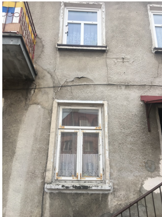
Fot. 6. Elewacja północna – zróżnicowanie kolorystyczne wypraw tynkarskich spowodowane naprawami, spękania i odspojenia tynku .
