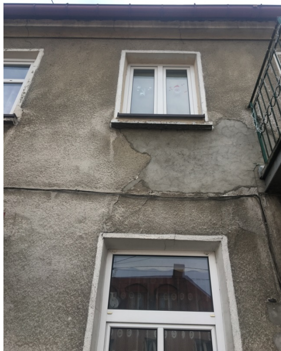
Fot. 4. Elewacja północna – zróżnicowanie kolorystyczne wypraw tynkarskich spowodowane naprawami .
