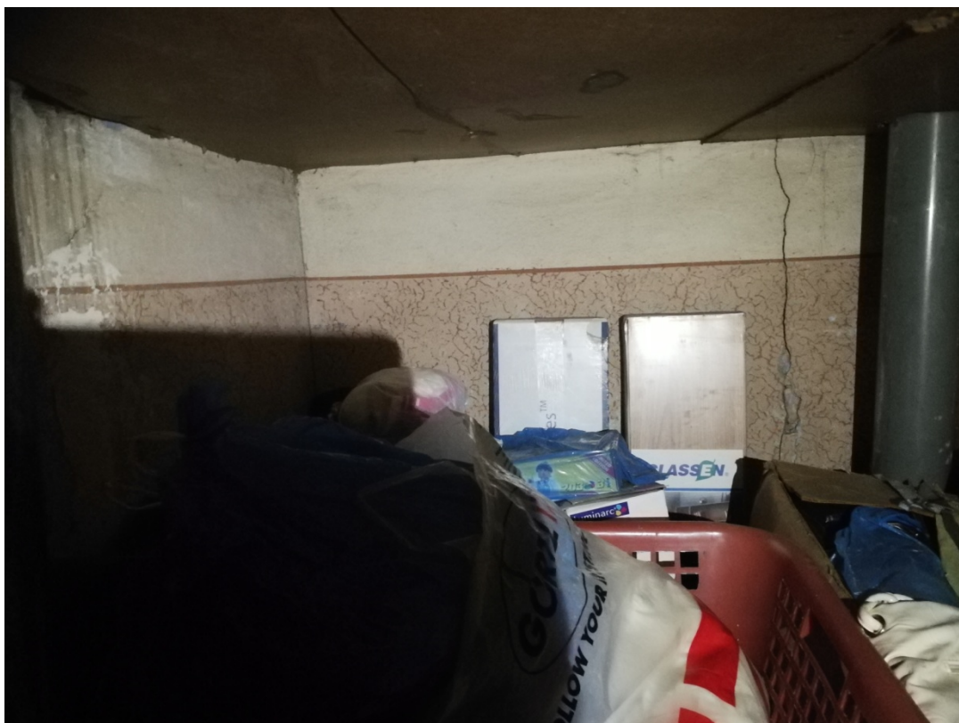
Fot. 21 Widoczne spękania ścian wewnętrznych - klatki schodowej
