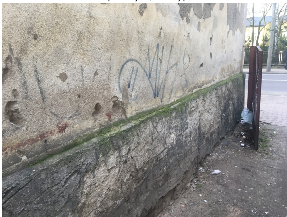
Fot. 4. Elewacja wschodnia– cokół - rozwój porostów.
