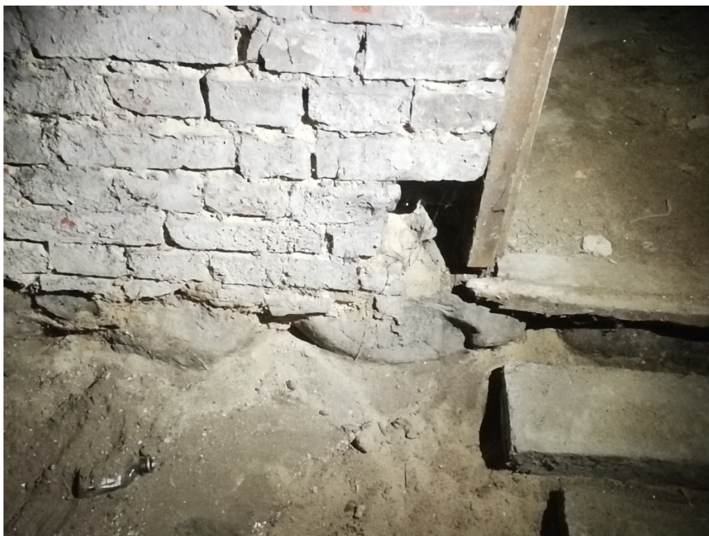
Fot. 15. Widok na górną część ław fundamentowych oraz ubytki w substancji ścian fundamentowych na kondygnacji piwnicy.
