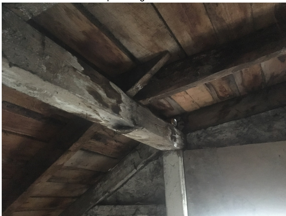
Fot. 12. Klatka schodowa w elewacji północnej – ślady wykwitów solnych po zawilgoceniach.
