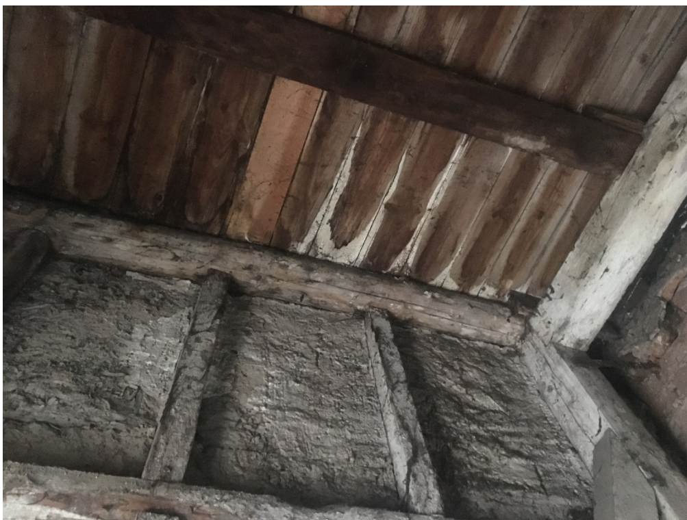
Fot. 11. Klatka schodowa w elewacji północnej – ślady wykwitów solnych po zawilgoceniach.
