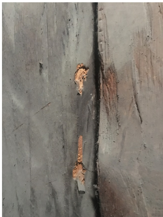
Fot. 13. Poddasze – aktywne żerowisko chrząszcza.
