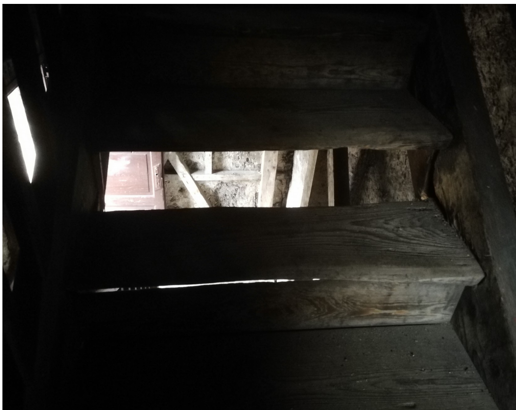
Fot. 23. Klatka schodowa – ubytki elementów drewnianych.
