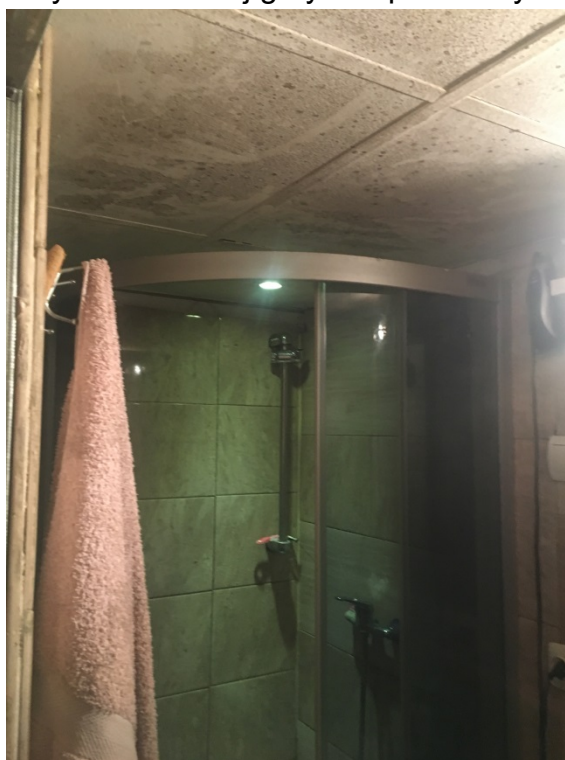
Fot. 16. Lokal mieszkalny nr 3 - rozwój grzybów pleśniowych na suficie w łazience.
