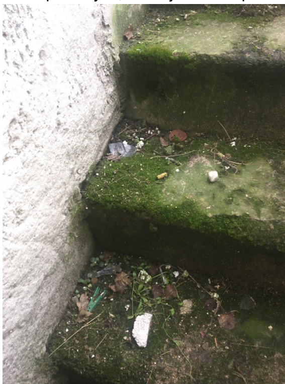
Fot. 10. Elewacja południowa – schody do piwnic, zawilgocenia od wód opadowych, rozwój mchów i porostów.
