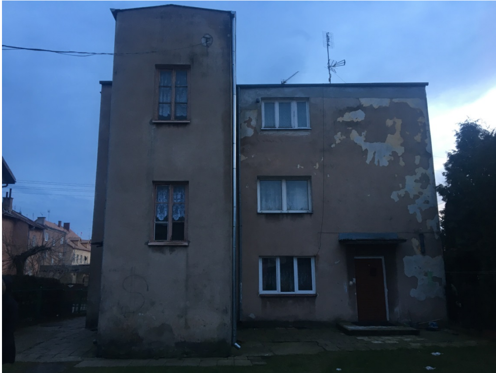
Fot. 12. Elewacja północna – widoczne nowe rynny i rury spustowe, ubytki powłok malarskich i wypraw tynkarskich, zawilgocenia w strefie cokołu.
