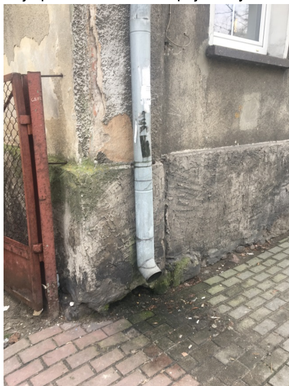
Fot. 2. Elewacja północna zawilgocenia fundamentów wodami opadowymi, rozwój porostów.
