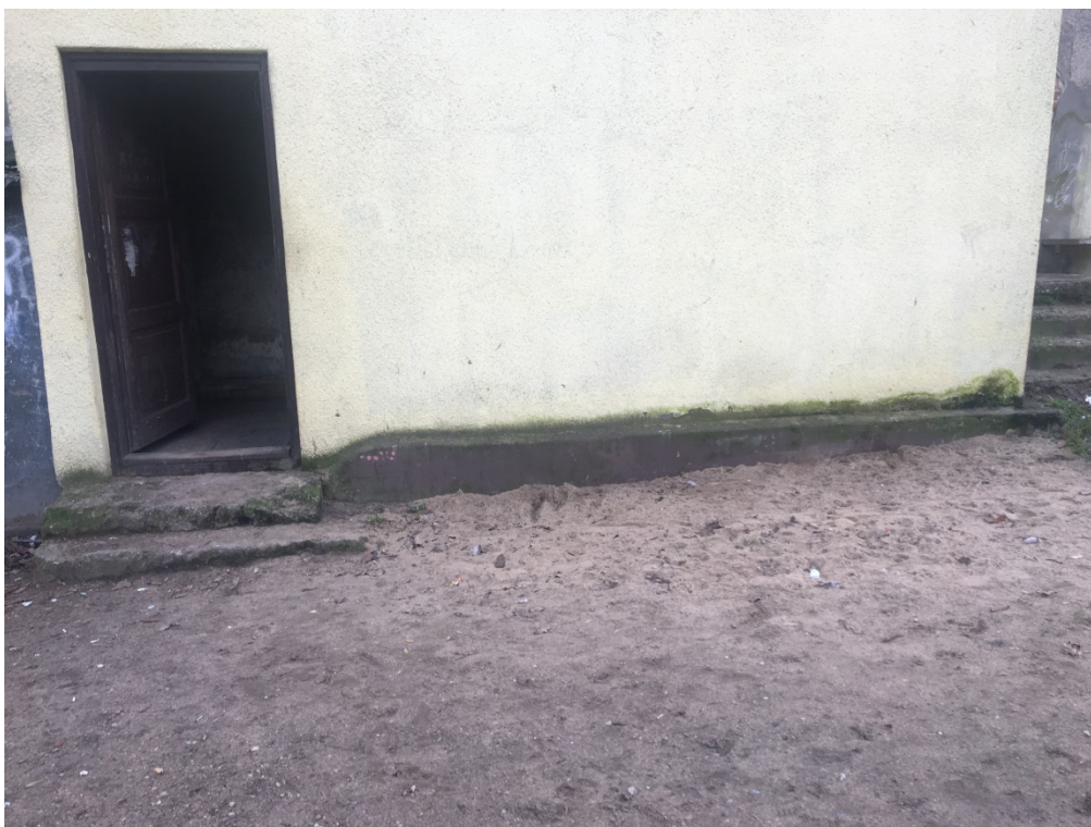
Fot. 7. Elewacja północna – wejście do klatki schodowej, rozwój mchów i porostów w strefie cokołu.
