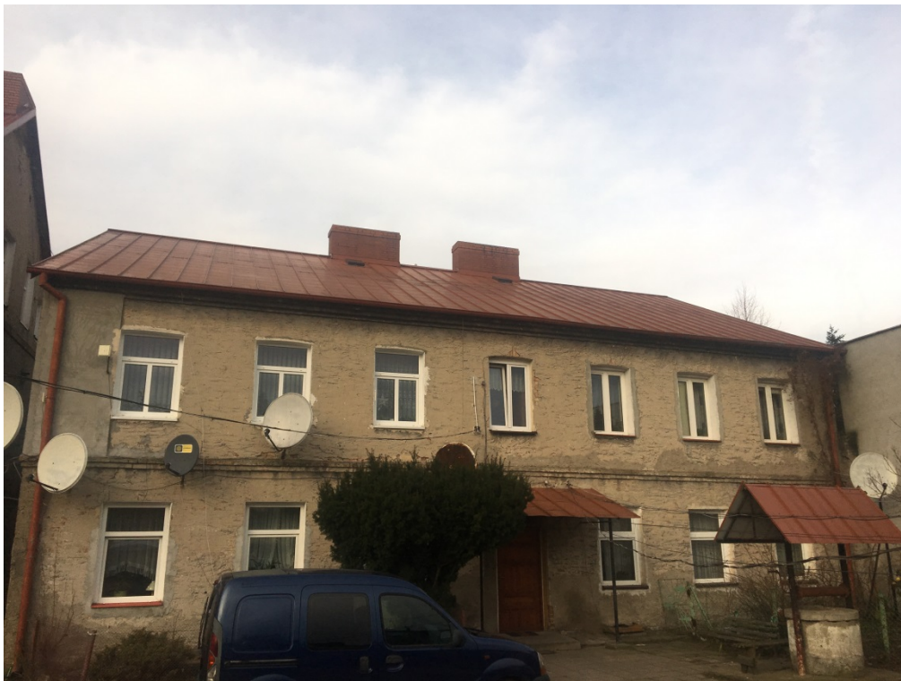
Fot. 8. Elewacja południowa – uszkodzenia tynku i przebarwienia na całej powierzchni elewacji.
