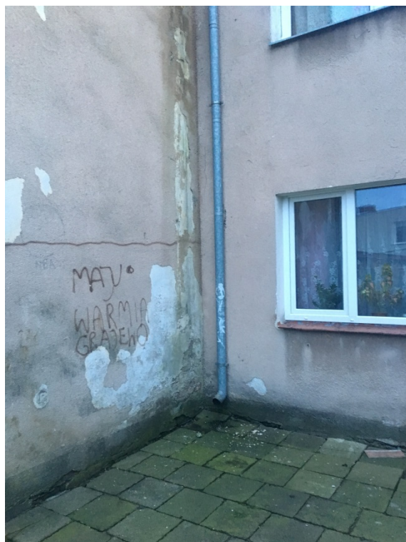
Fot.16. Elewacja pn.-zach. – uszkodzenia narożnika spowodowane wodami opadowymi odprowadzanymi na chodnik.
