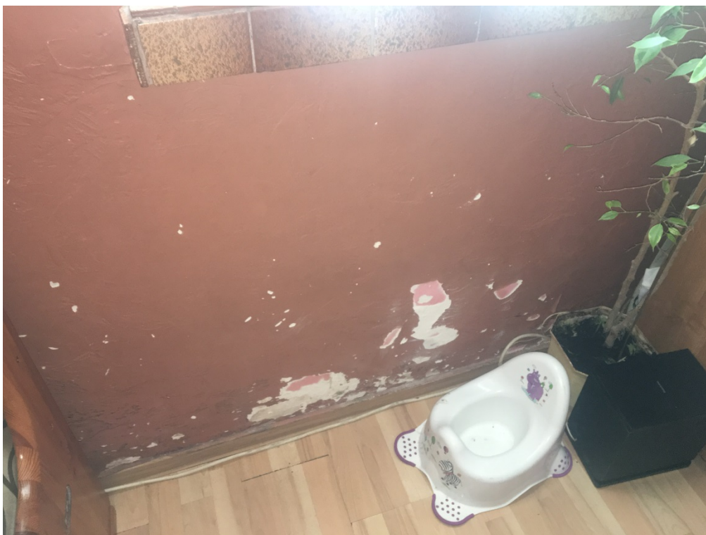
Fot. 11. Lokal mieszkalny nr... - uszkodzenie powłok malarskich i gładzi w strefie przypodłogowej.
