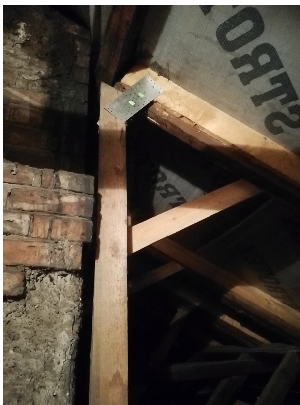
Fot. 12. Wzmocnienia elementów konstrukcyjnych więźby dachowej.
