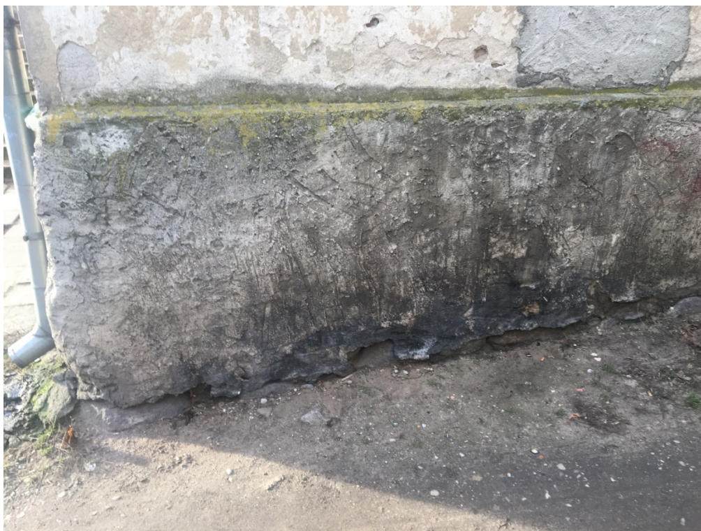
Fot. 5. Elewacja wschodnia - cokół -rozwój porostów.
