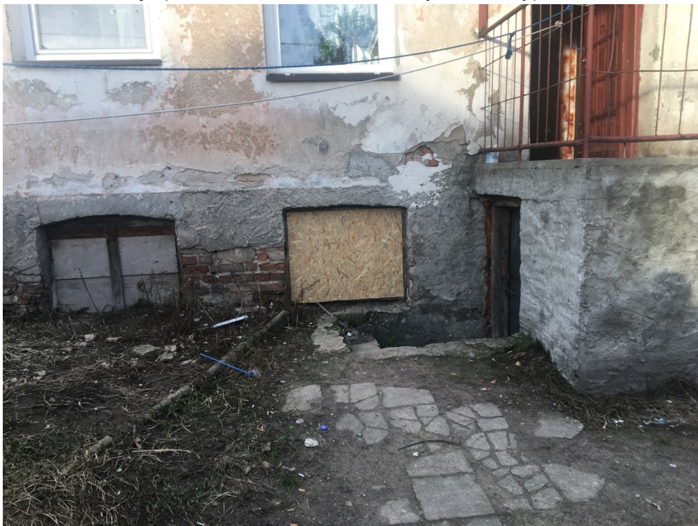
Fot. 10. Elewacja południowa – uszkodzenia tynków i wypraw malarskich.
