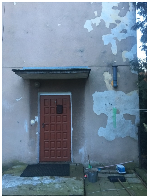
Fot. 17. Elewacja północna –ubytki powłok malarskich i wypraw tynkarskich.
