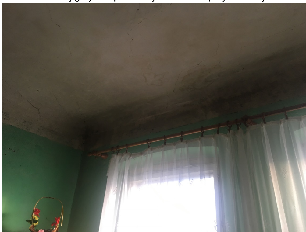
Fot. 14. Lokal mieszkalny nr... - uszkodzenie powłok malarskich rozwój grzybów pleśniowych w strefie przysufitowej.
