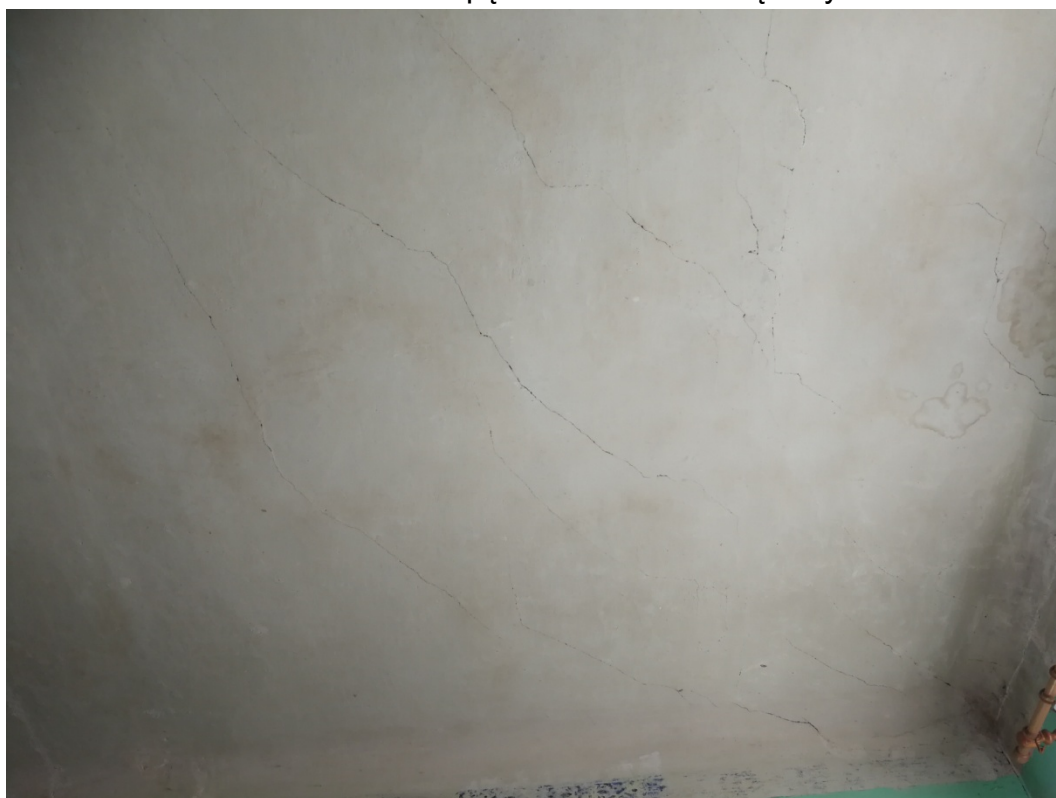
Fot. 20 Widoczne spękania stropów.
