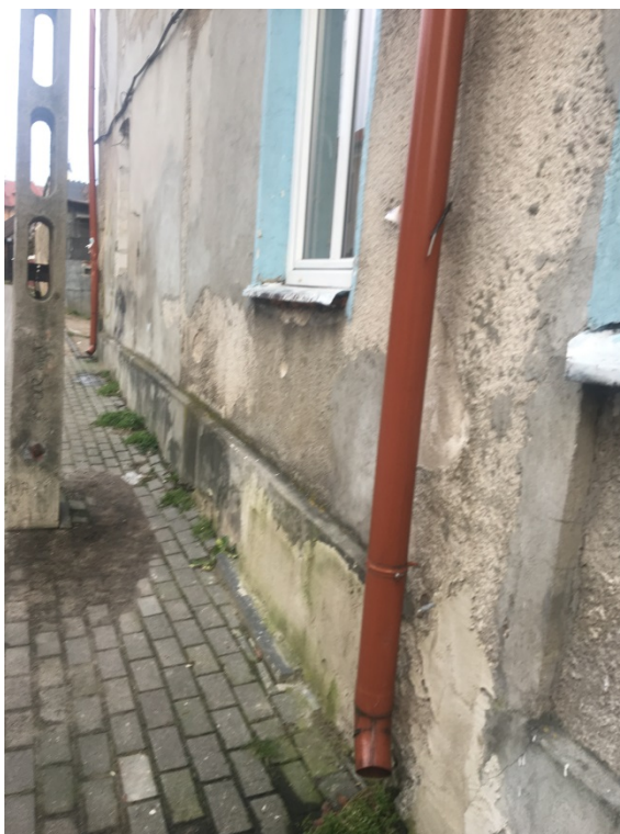
Fot. 3. Elewacja zachodnia – zawilgocenia strefy cokołowej, liczne odspojenia i spękania tynku.
