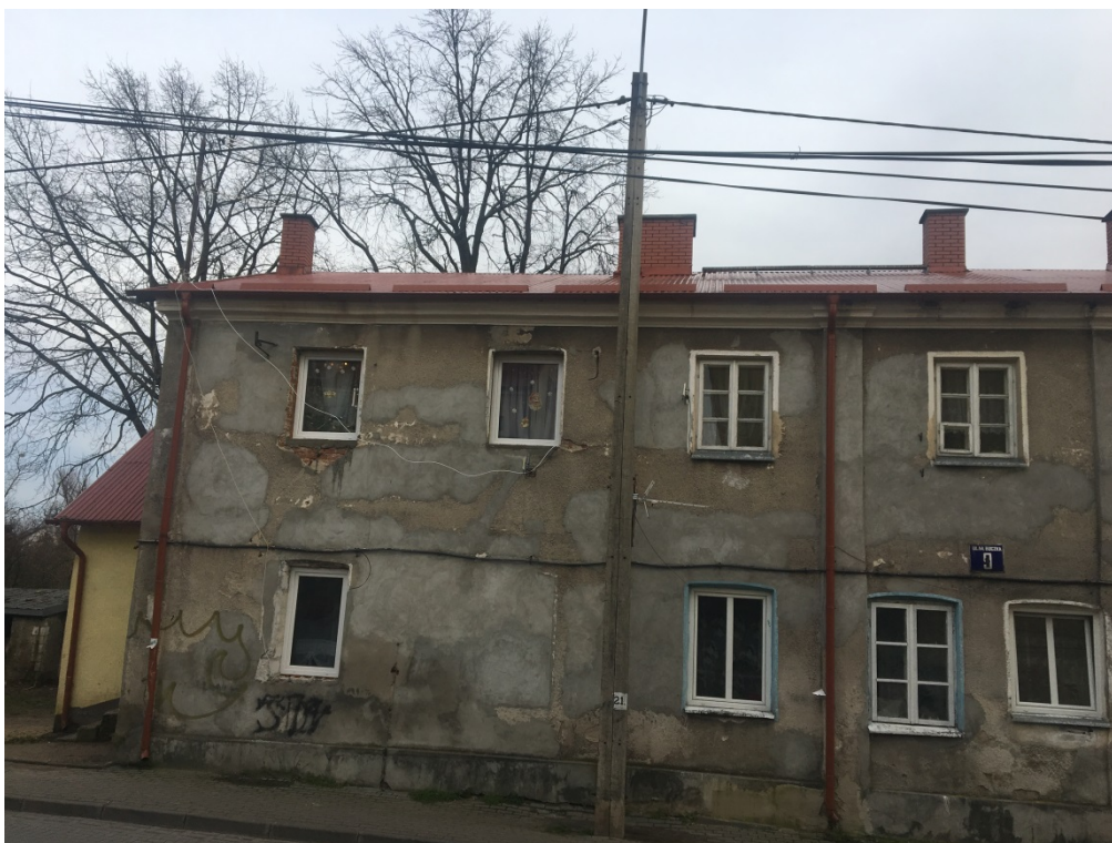
Fot. 1. Elewacja zachodnia – słabe wyprawy tynkarskie, liczne odspojenia i spękania.
