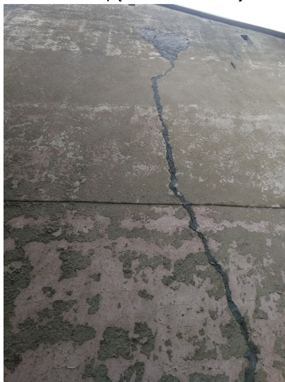
Fot. 22 Widoczne pęknięcie ściany bocznej na całości elewacji od strony działki nr ewid. 1371
