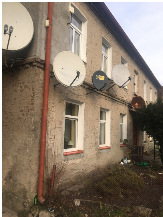
Fot. 9. Elewacja południowa – uszkodzenia tynku i przebarwienia na całej powierzchni elewacji.
