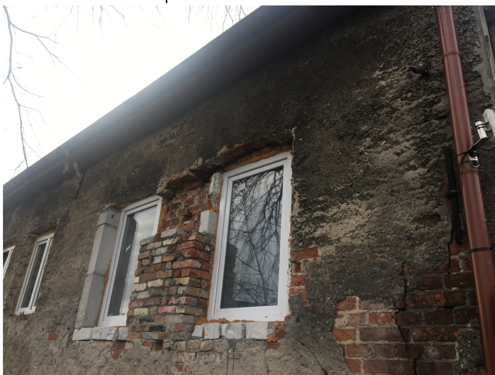
Fot. 8. Elewacja wschodnia– konstrukcyjne spękania muru, ściana w trakcie częściowego przemurowania po wymianie stolarki okiennej.
