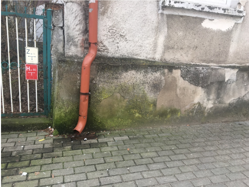
Fot. 7. Elewacja północna – uszkodzenia cokołu przy rurze spustowej, rozwój porostów w strefie cokołowej.
