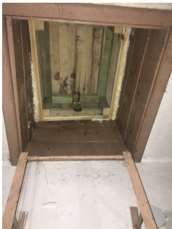
Fot. 21. Klatka schodowa – wyjście na dach -rozwój grzybów pleśniowych na drewnianej kłapieżamykającej.
