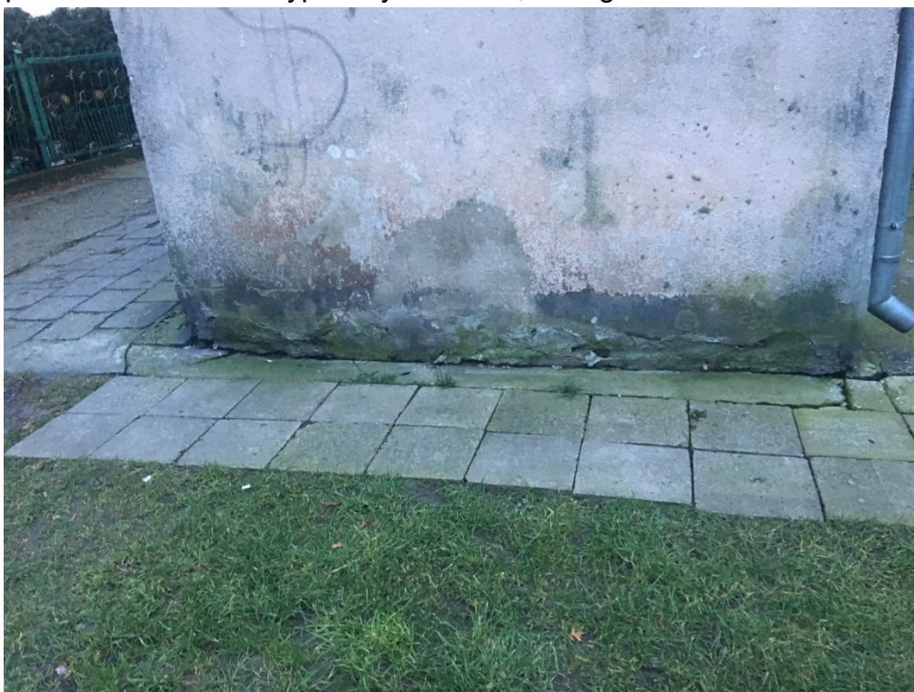
Fot. 13. Elewacja północna – klatka schodowa - uszkodzenia tynków w strefie przyziemia, porażenie biologiczne grzybami pleśniowymi i porostami.
