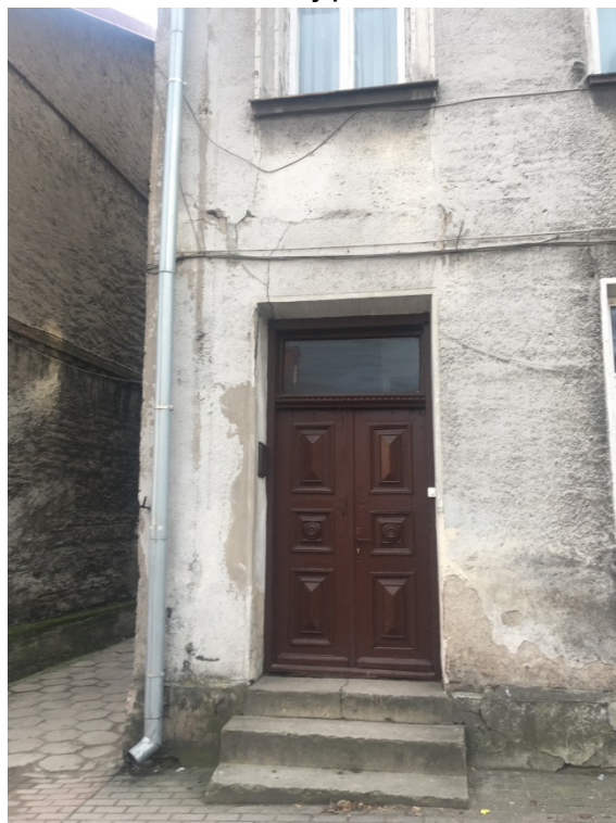
Fot. 2. Elewacja północna – uszkodzenia cokołu przy rurze spustowej, rozwój porostów w strefie cokołowej.
