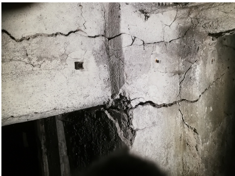
Fot. 24. Ściany wewnętrzne konstrukcyjne – piwnica - konstrukcyjne spękania ścian.
