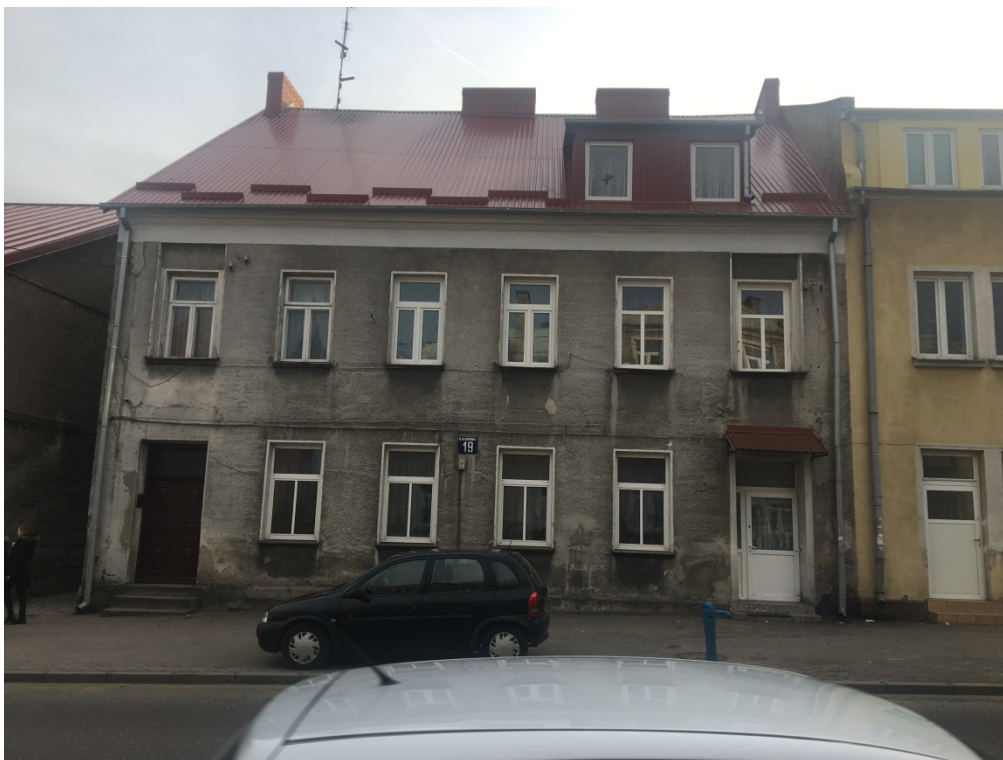
Fot. 1. Elewacja północna – frontowa uszkodzenia tynku i brudne przebarwienia na całej powierzchni elewacji.
