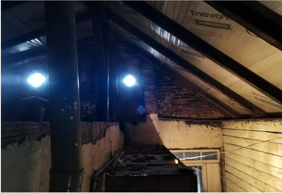
Fot. 27. Korytarz strych – przestrzeń strychu zaadaptowana na korytarz. Brak ocieplenia.
