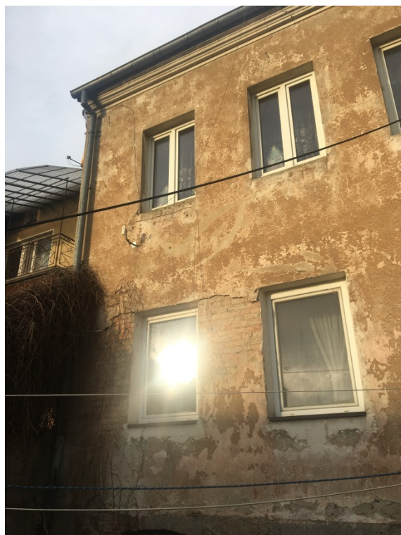
Fot.11. Elewacja południowa – uszkodzenia tynków i wypraw malarskich.
