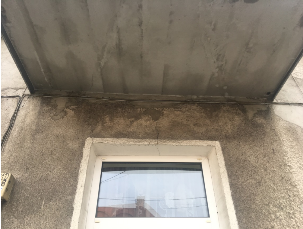
Fot. 3. Elewacja północna – frontowa uszkodzenia tynku pęknięcie muru w strefie nadproża okiennego.
