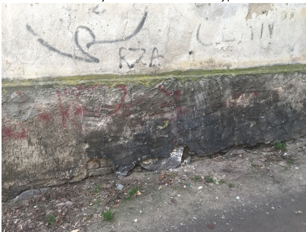
Fot. 6. Elewacja wschodnia - cokół -rozwój porostów.
