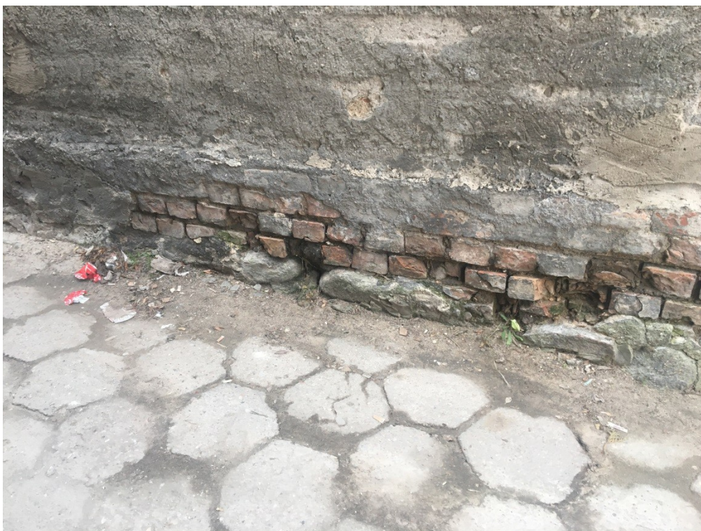
Fot. 7. Elewacja wschodnia – uszkodzenia cokołu ubytki w murze ceglanym.
