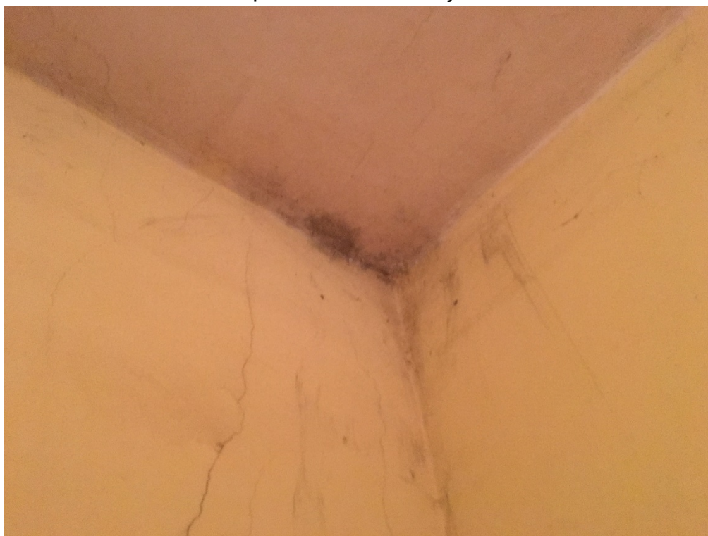
Fot. 10. Lokal mieszkalny nr ... – uszkodzenia tynku i przebarwienia powłok malarskich, ślady rozwoju grzybów pleśniowych w narożu.
