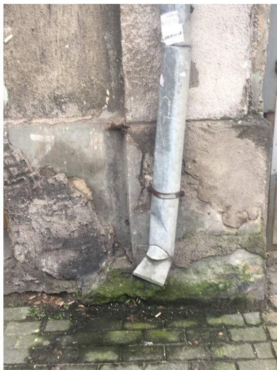
Fot. 3. Elewacja północna zawilgocenia fundamentów wodami opadowymi, rozwój porostów.
