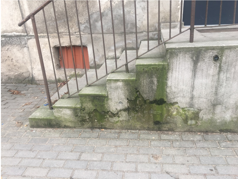
Fot. 5. Elewacja północna – schody wejściowe do budynku, rozległe uszkodzenia budulca, rozwój mchów i porostów.
