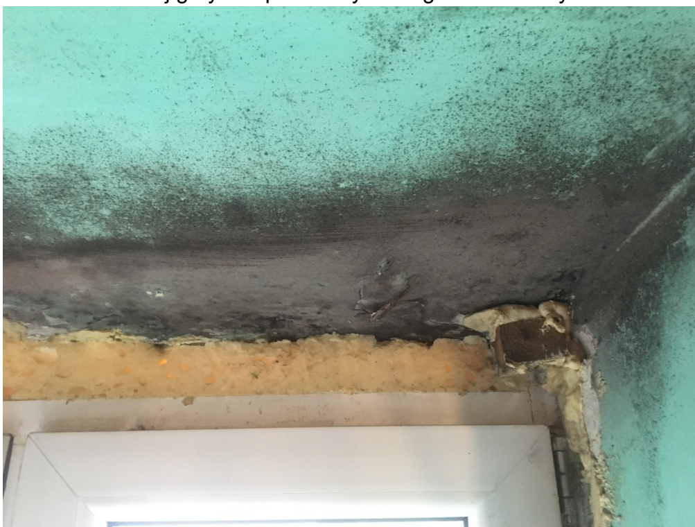
Fot. 18. Lokal mieszkalny nr 3 - rozległe powierzchnie porażenia biologicznego, rozwój grzybów pleśniowych na glifach okiennych.
