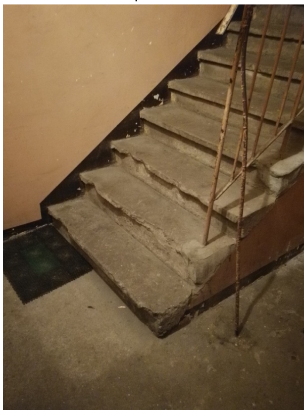
Fot. 31 Widoczne uszkodzenia podstopni i stopni na klatce schodowej.
