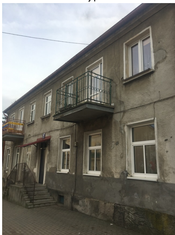
Fot. 2 . Elewacja północna – frontowa uszkodzenia tynku i odbarwienia na całej powierzchni elewacji.
