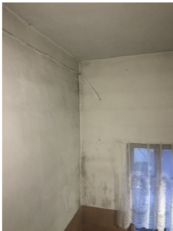
Fot. 20. Klatka schodowa – rozwój grzybów pleśniowych w narożu pod sufitem, złuszczenia powłok malarskich.
