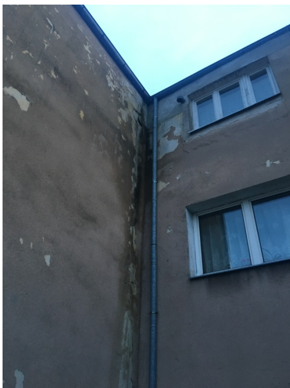
Fot.15. Elewacja pn.-zach. – uszkodzenia narożnika po przeciekach wód opadowych z nieszczelnych rynienprzed wymianą na nowe.
