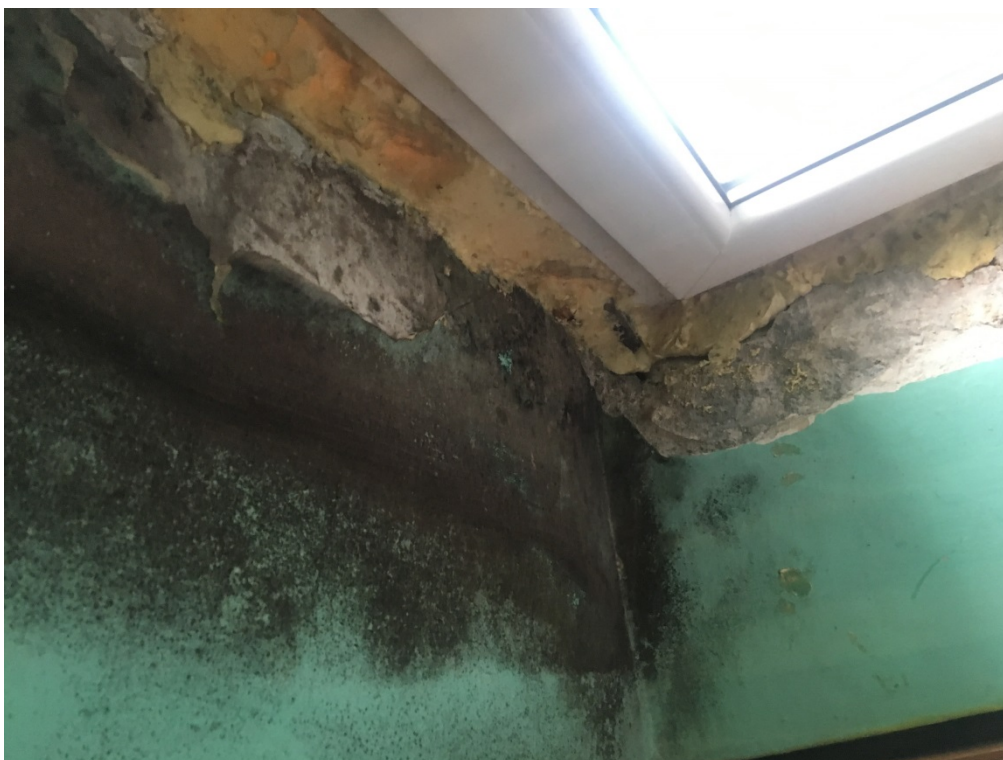
Fot. 17. Lokal mieszkalny nr 3 - rozległe powierzchnie porażenia biologicznego, rozwój grzybów pleśniowych na glifach okiennych.
