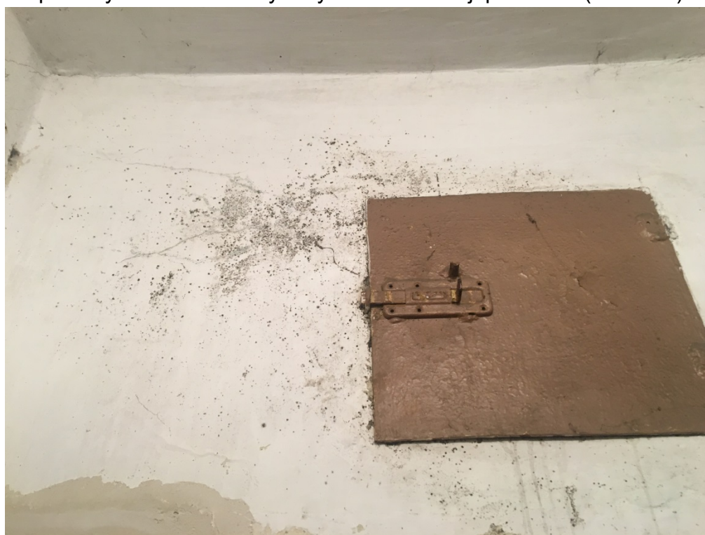
Fot. 19. Klatka schodowa – rozwój grzybów pleśniowych.
