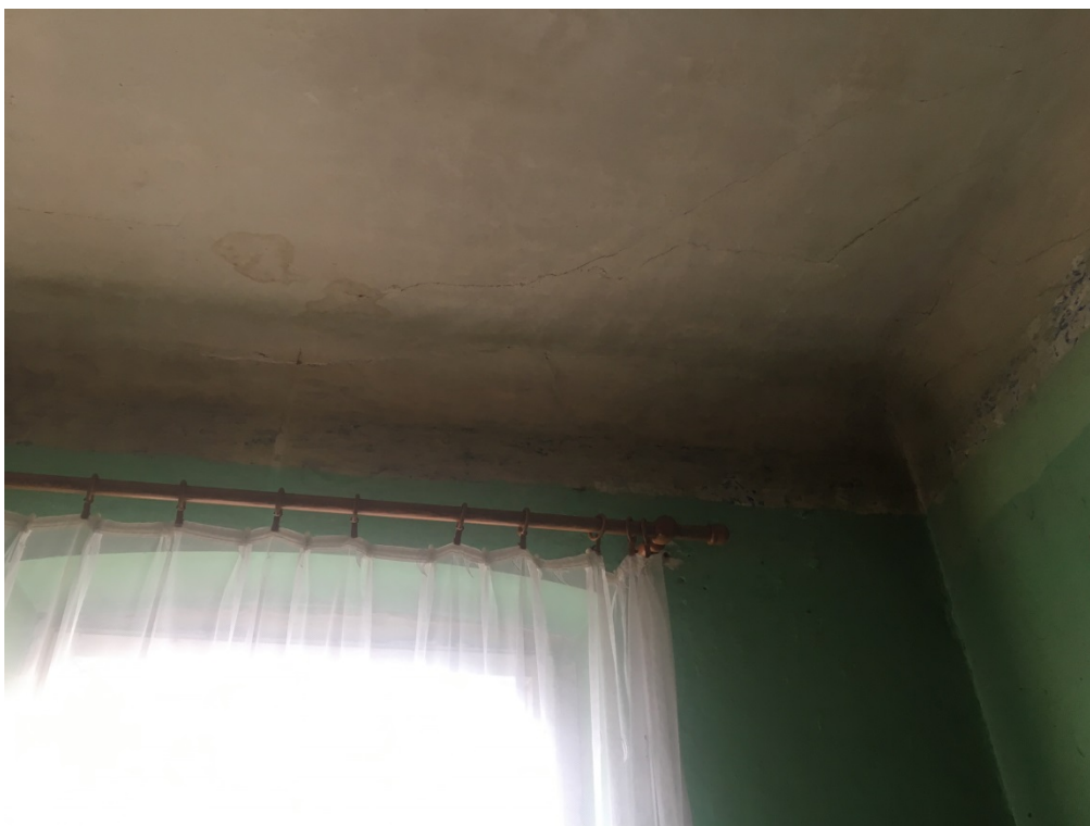
Fot. 13. Lokal mieszkalny nr... - uszkodzenie powłok malarskich rozwój grzybów pleśniowych w strefie przysufitowej.
