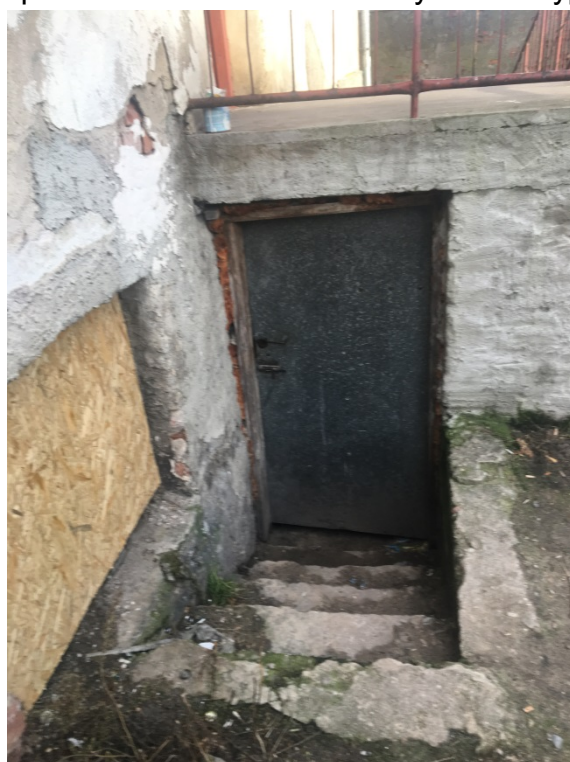
Fot.12. Elewacja południowa – wejście do piwnic, uszkodzenia schodów betonowych, rozwój porostów.
