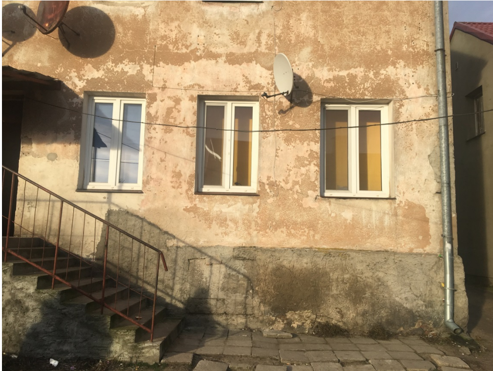
Fot.9. Elewacja południowa–uszkodzenia tynków i wypraw malarskich.
