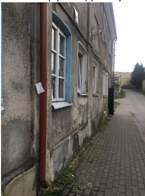
Fot. 4. Elewacja zachodnia – zawilgocenia strefy cokołowej, liczne odspojenia i spękania tynku.
