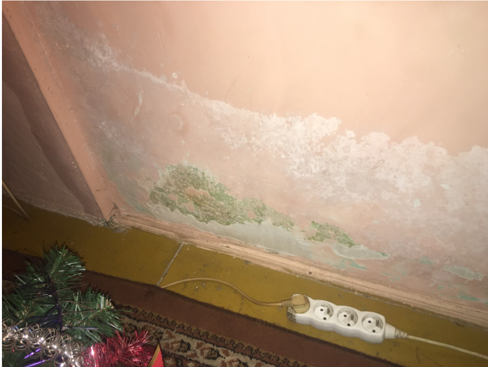
Fot. 26. Lokal mieszkalny nr ... - ściana od ul. Kilińskiego – zawilgocenia w strefie przypodłogowej, uszkodzenia spowodowane krystalizacją soli budowlanych.
