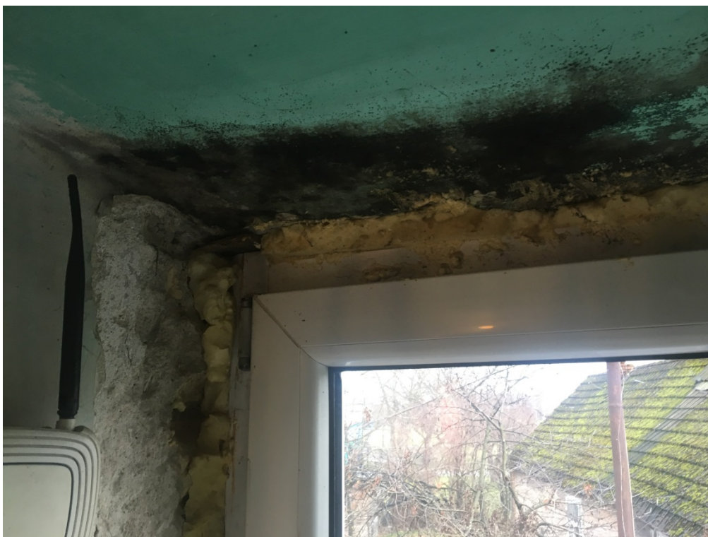
Fot. 19. Lokal mieszkalny nr 3 - rozległe powierzchnie porażenia biologicznego, rozwój grzybów pleśniowych na glifach okiennych.
