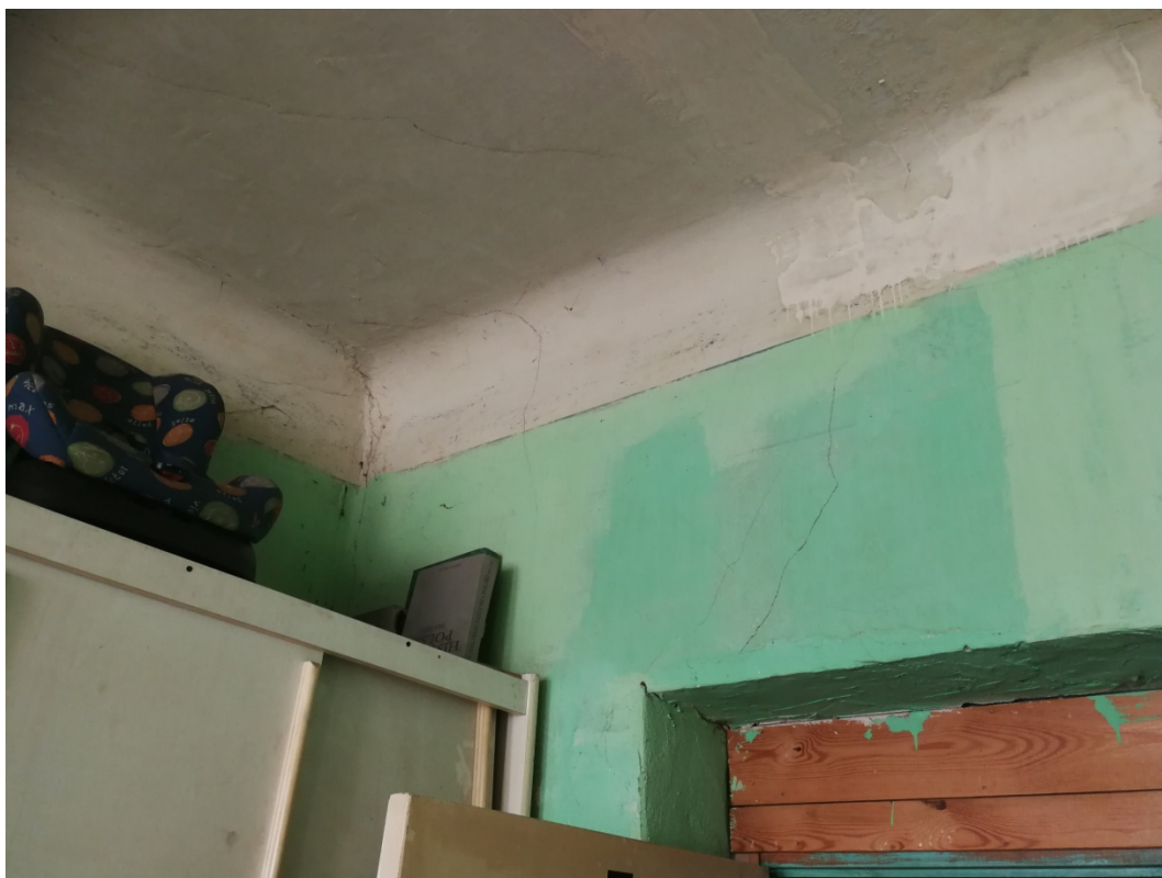
Fot. 17 Widoczne spękania ścian wewnętrznych
