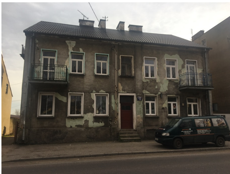
Fot. 1. Elewacja północna duże odspojenia tynku elewacyjnego
