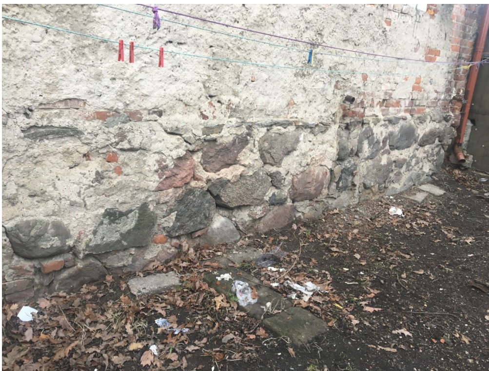
Fot. 9. Elewacja wschodnia– konstrukcyjne spękania fundamentu kamiennego.
