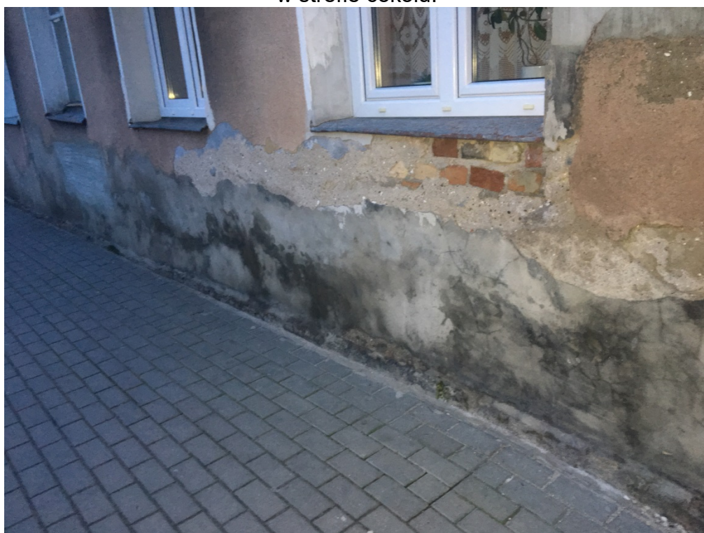
Fot.2. Elewacja południowa – uszkodzenia wypraw tynkarskich w strefie cokołu, ślady po zawilgoceniu, korozja parapetów.
