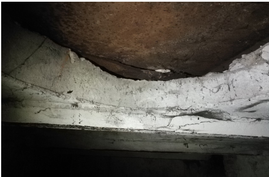
Fot. 25. Strop nad piwnicą – otwory w stropie o średnicy 100 cm.
