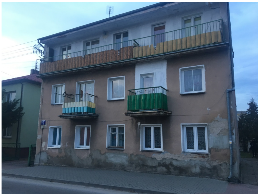
Fot.1. Elewacja południowa – uszkodzenia wypraw tynkarskich w strefie cokołu.
