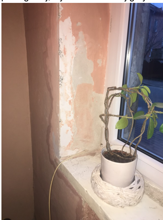
Fot. 25. Lokal mieszkalny nr ... - ściana od ul. Kilińskiego – zawilgocenia ściany , uszkodzenia spowodowane krystalizacją soli budowlanych.
