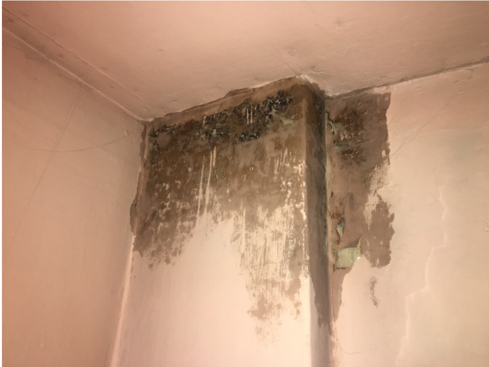
Fot. 15. Lokal mieszkalny nr ...- zacieki przy kominie spalinowym.
