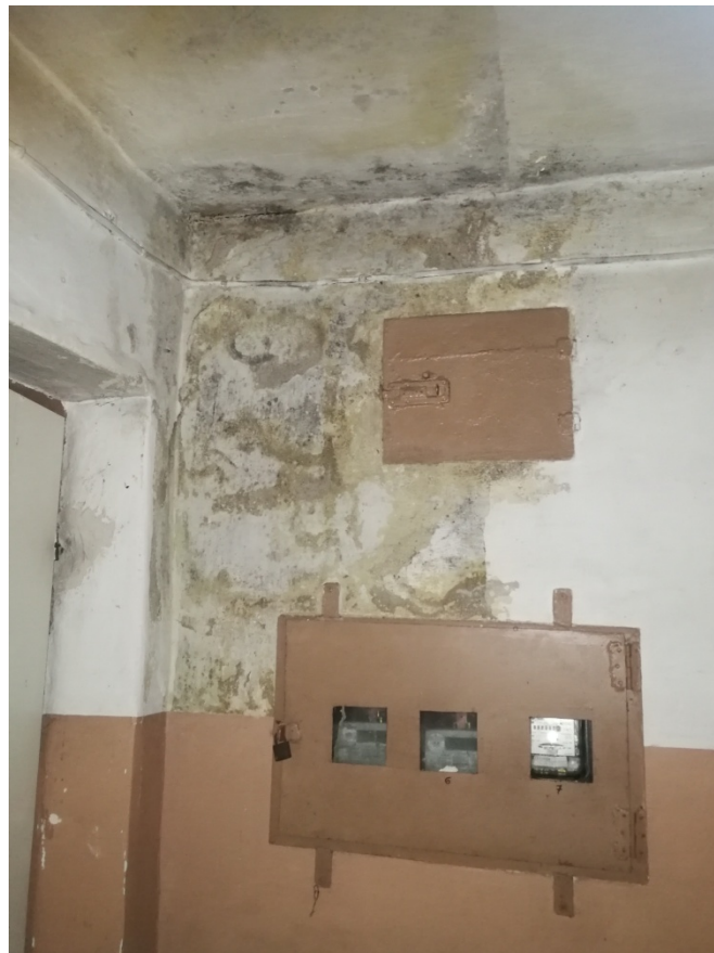
Fot. 28. Lokal mieszkalny nr ... - ściana od ul. Kilińskiego – zawilgocenia w strefie przypodłogowej, wysolenia i rozwój grzybów pleśniowych.
