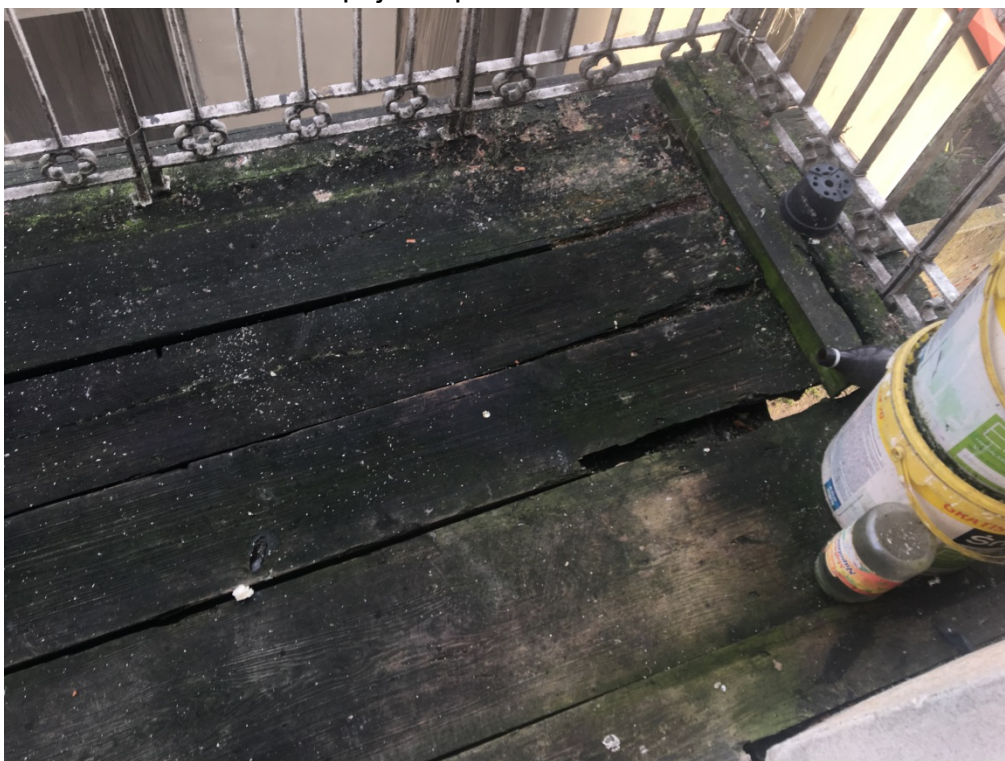
Fot. 8. Elewacja wschodnia - balkon – biologiczny rozkład desek balkonowych.
