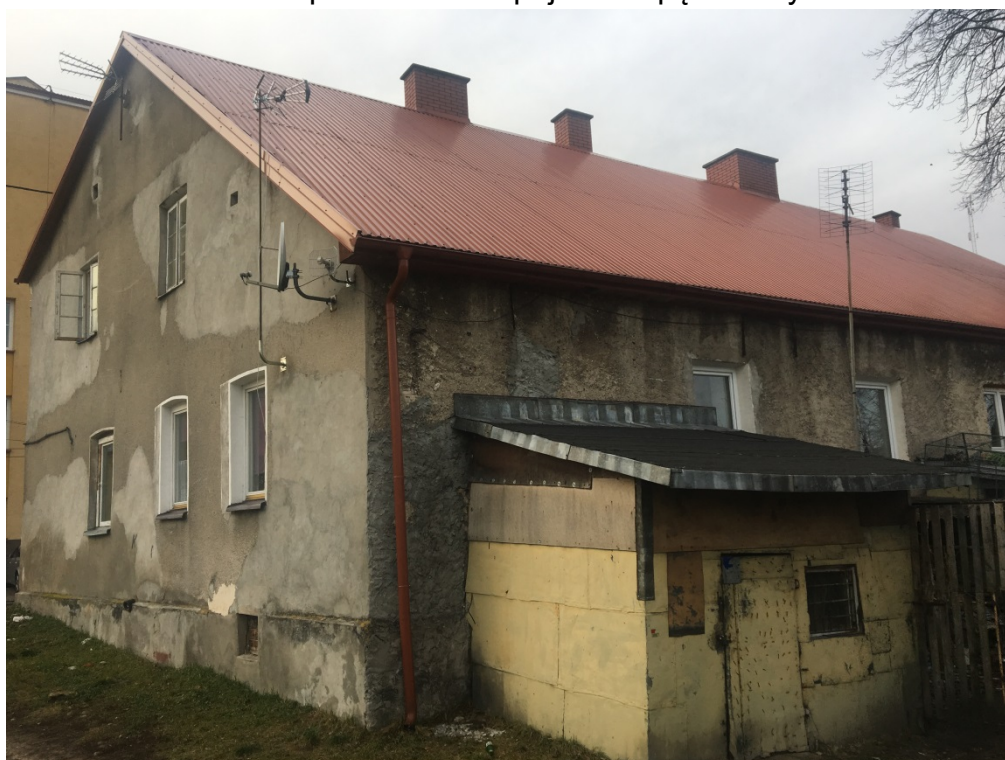
Fot. 6. Elewacja południowa i wschodnia – zawilgocenia strefy cokołowej, liczne uzupełnienia i naprawy tynku.
