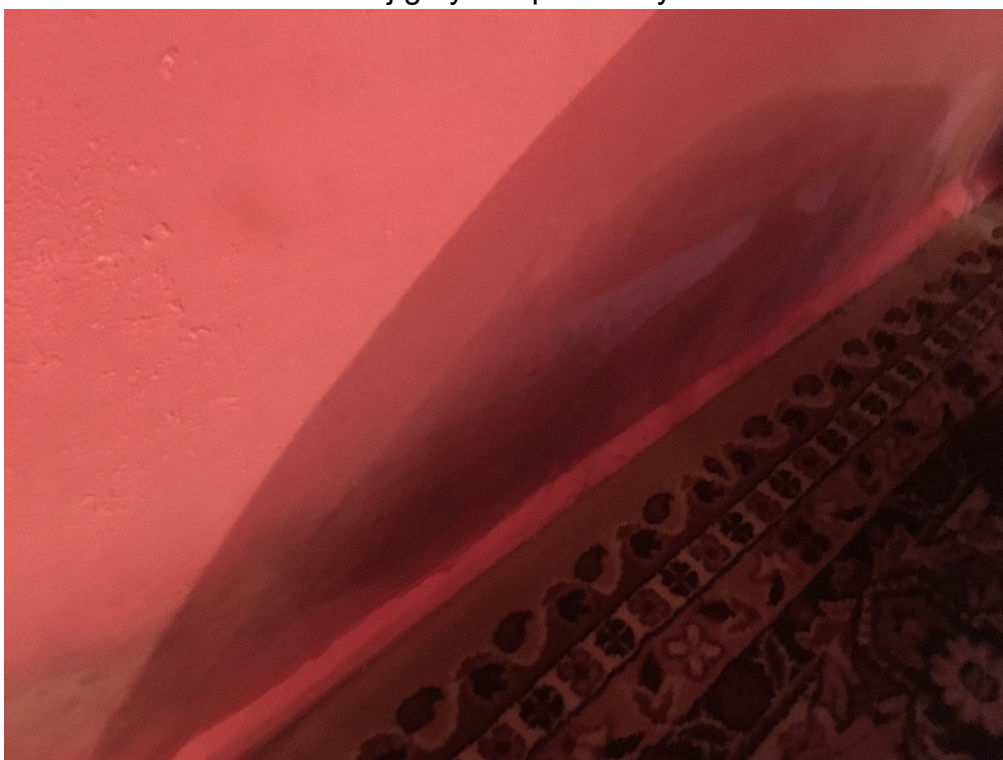
Fot. 14. Lokal mieszkalny nr 1 - wilgotne ściany przy podłodze, rozwój grzybów pleśniowych.
